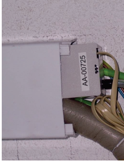
Figura 28 - Etiquetado de Bomba de Condensación
