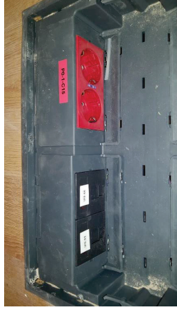
Figura 5 – Caja con mecanismos girados 90º y detalle
