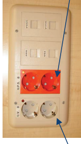
Figura 37 - Caja empotrada tipo 2UV+2EE+4TT
