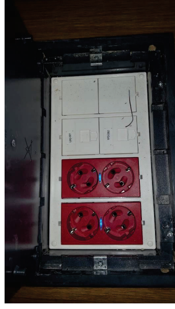
Figura 6 – Puesto de trabajo 2TT+4EE+1MC
