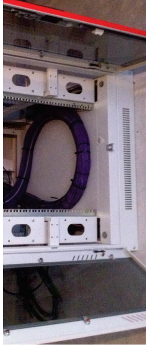
Figura 34- Ejemplo de coca ordenada en el interior del armario
