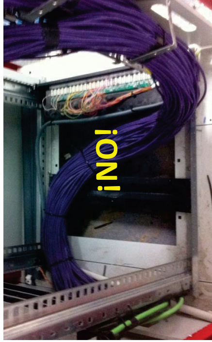
Figura 35- Ejemplos de coca indebida en el interior del armario
