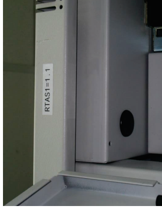
Figura 4 - Etiquetado de armario en repartidor compuesto por un único armario
