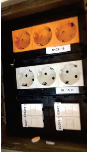
Figura 23 - Etiketado de Tomas Eléctricas
