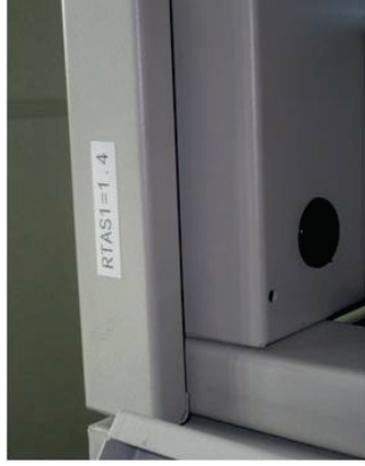
Figura 4 - Etiquetado de armario en repartidor compuesto por un único armario
