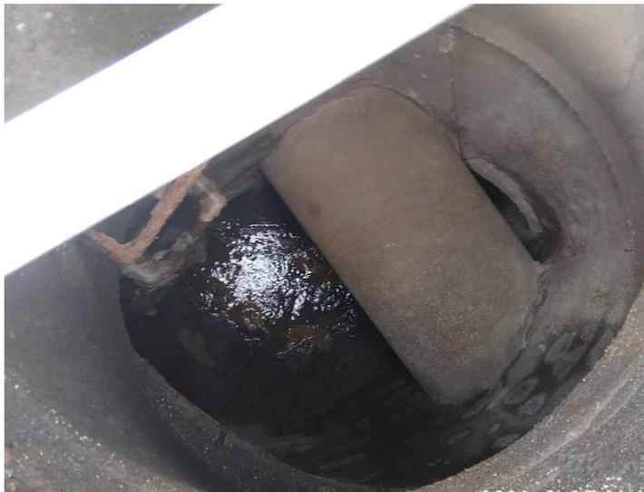
Por las razones indicadas, se ha renovado el colector verde, ajustando la pendiente, de forma que sea continua entre el pozo inicial y final, y con el diámetro y material indicado según el cálculo hidráulico.
