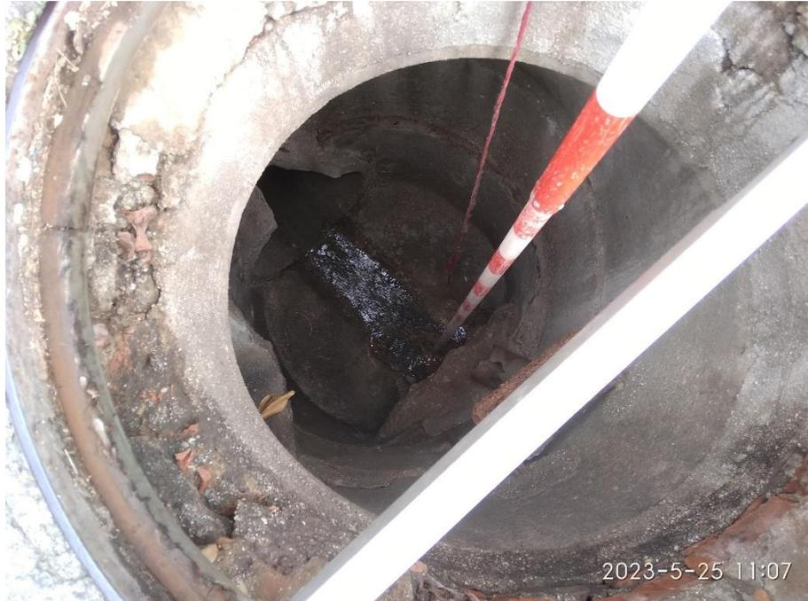
*Ilustración 11 Pozo existente a reconstruir P74BN-136 en la calle Cañadas del Teide.*
