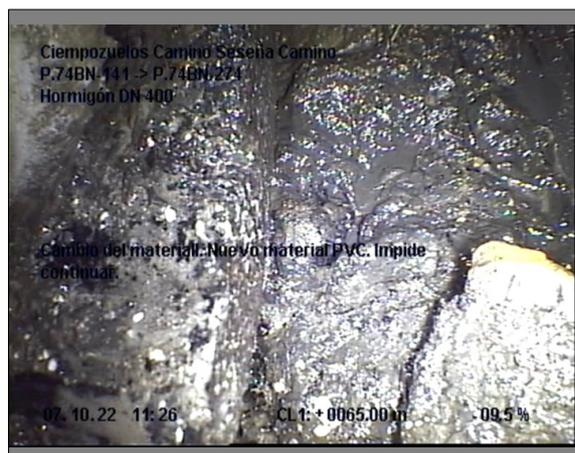
Foto: 07102022112334\_Camino Seseña\_S\_LineNumber.JPG 65m, Cambio del material. Nuevo material PVC. Impide continuar.
