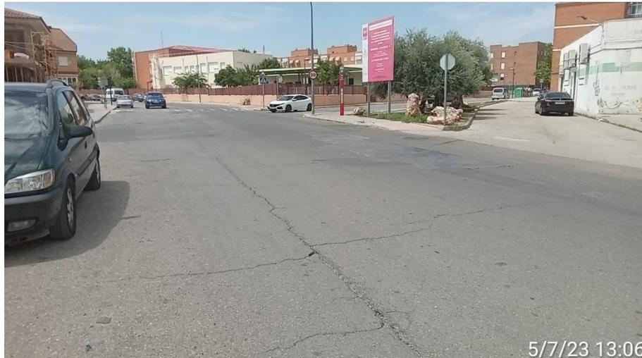
*Ilustración 18 Estado del pavimento en las cercanías de la calle Caldera de Taburiente.*
