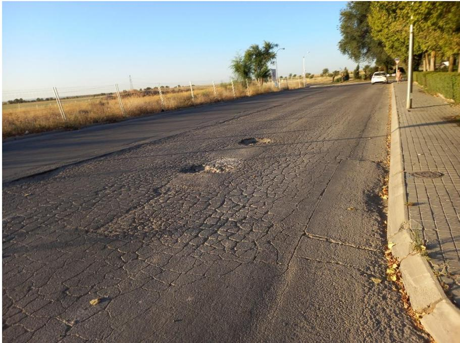
*Ilustración 25 Estado del pavimento en las proximidades del cruce con la calle Cañadas del Teide.*
