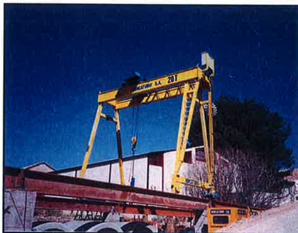
Figura 11.- Pórtico grúa para retirar las vagonetas llegadas al pozo de ataque
