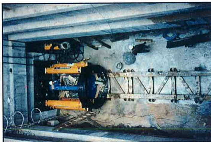
Figura 4.- Presentación de los gatos hidráulicos sobre el bastidor
