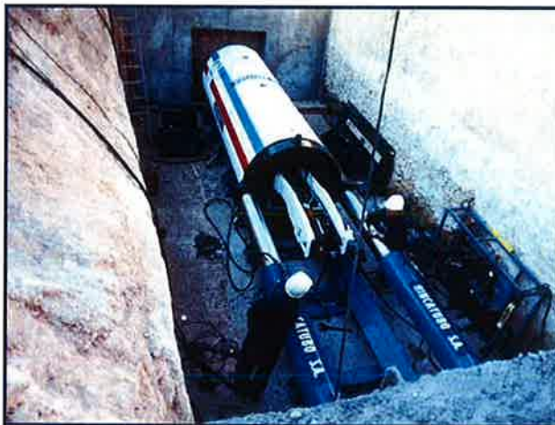
Figura 2.- Pozo de ataque correspondiente al sistema de hinca con escudo abierto
