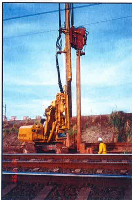
Figura 18.- Detalle de colocación de tablestacas en la protección de una línea de ferrocarril
