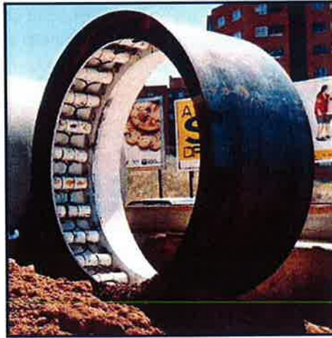
Figura 13.- Virola que se utiliza para crear la estación intermedia
