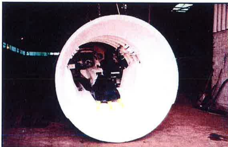
Figura 6.- Detalle del brazo o escudo abierto con excavadora o retro
