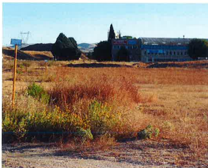
INSTALACIONES DE GAS
