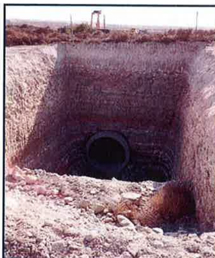
Figura 12.- Pozo de salida
