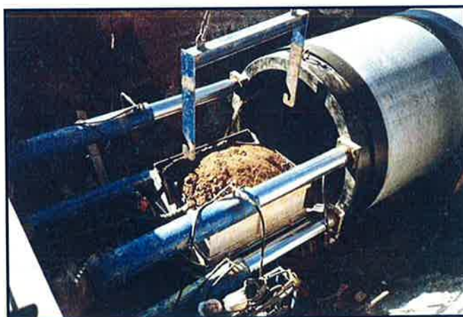
Figura 10.- Vagoneta llena en el pozo de ataque para ser evacuada
