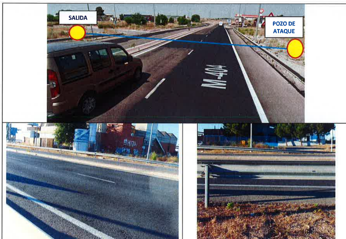
Figura 1.- Zona de hinca bajo la carretera M-404
