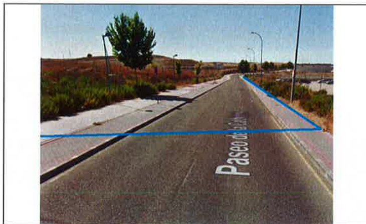
Figura 3.- Afección al Paseo de la Calderona
