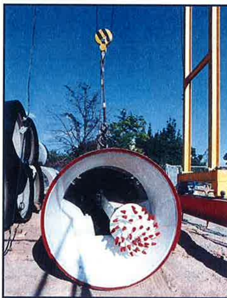
Figura 7.- Detalle del brazo o escudo abierto con rozadora
