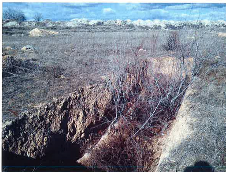
Fotografía 4. Calicata existe realizada a escasos metros del sondeo S-1
