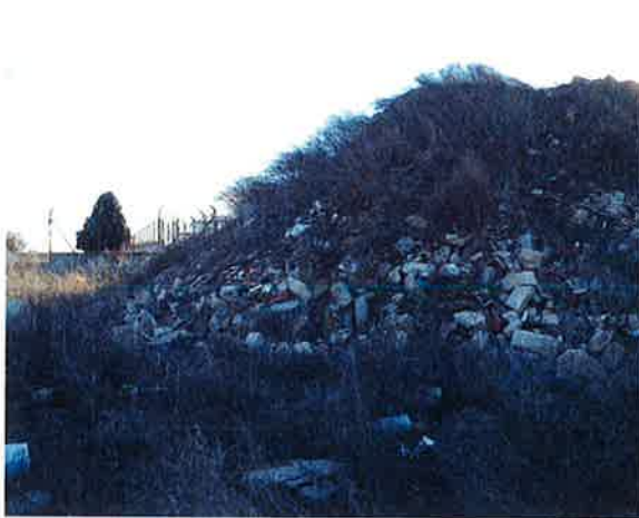
Fotografía 8: Rellenos antrópicos. Escombros y restos de tierras sobrantes. Parte media del trazado
