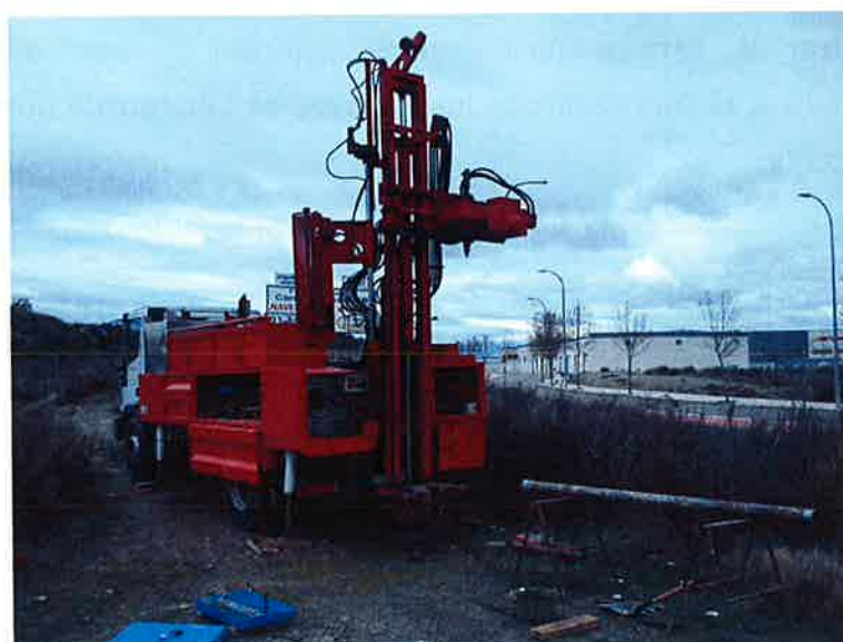
Fotografía 2: Máquina de sondeos Mobile Drill durante la ejecución del sondeo S-2 junto al Arroyo de la Cañada. Fin tramo.
