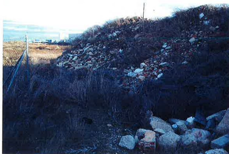
Fotografía 3. Acumulación de rellenos antrópicos vertidos (arenas con abundantes escombros). Parte media del trazado.
