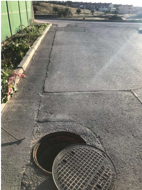
Pozo P.55QJ-526. Avda. Guadalajara vista hacia aguas arriba
