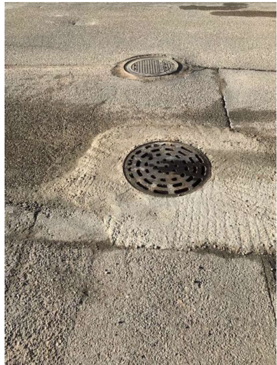
Pozo P.55QJ-637. Vista desde C/ Copenhague hacia C/ Ámsterdam
