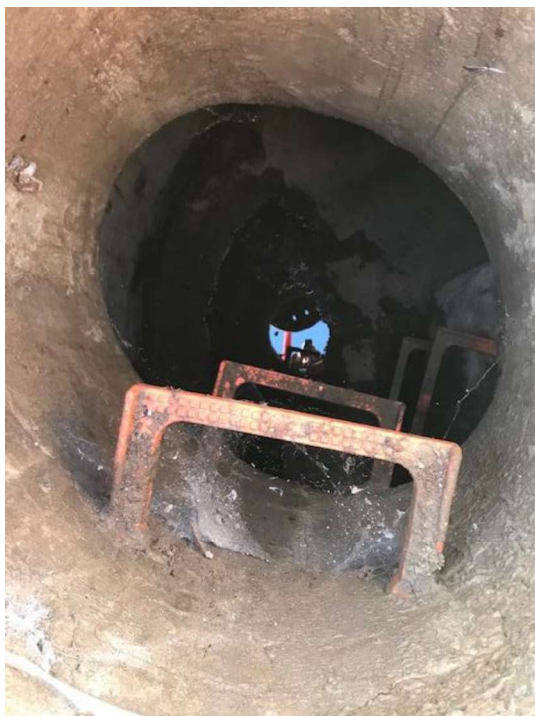
Pozo P.55QJ-428. Pº de Pozuelo Vista del interior
