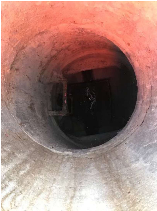
Pozo P.55QJ-488. Vista del interior
