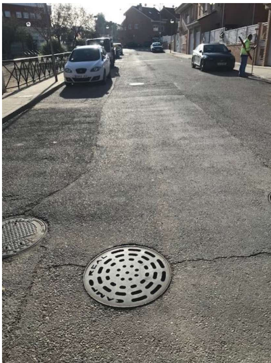
Pozo P.55QJ-460. C/ Ámsterdam vista hacia aguas arriba
