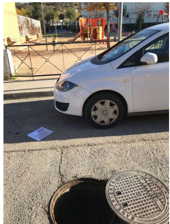
Pozo P.55QJ-461. C/ Ámsterdam junto a parque
