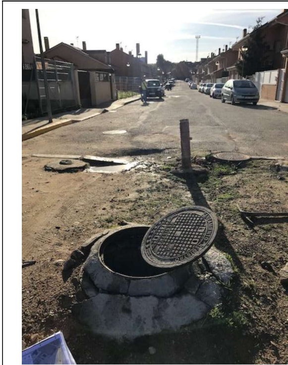
Pozo P.55QJ-453. Vista hacia C/ Ámsterdam
