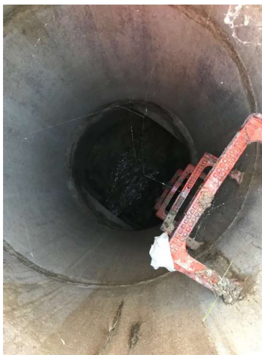
Pozo P.55QJ-486. Vista del interior
