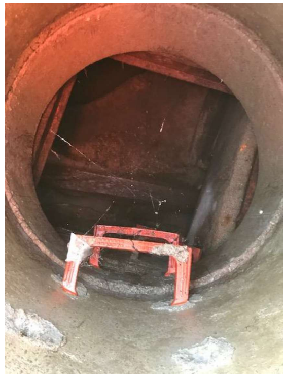
Pozo P.55QJ-526. Vista del interior
