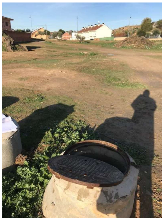
Pozo P.55QJ-486. Avda. Europa vista hacia aguas abajo
