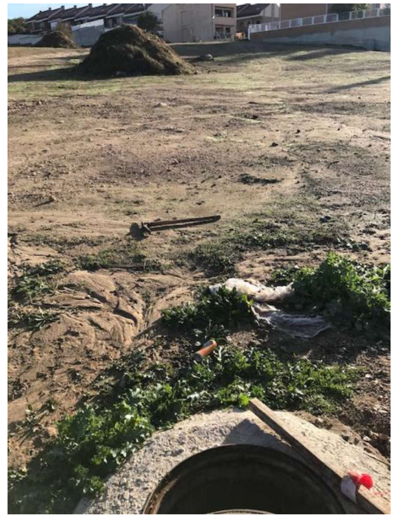
Pozo P.55QJ-488. Avda. Europa vista hacia Pozo Sin Numerar
