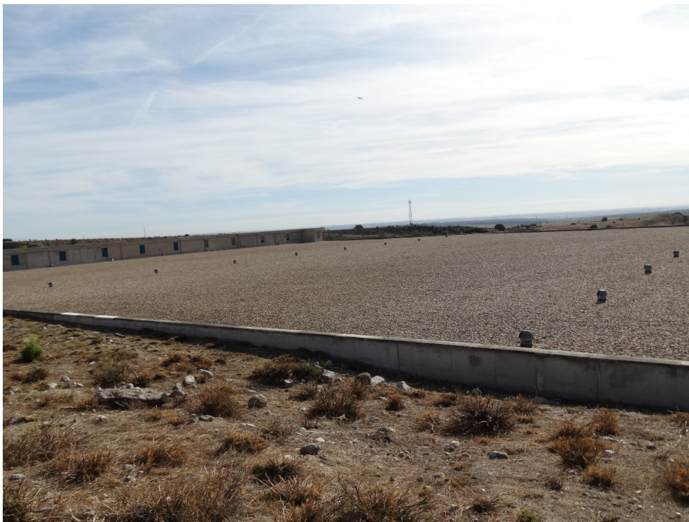
Imagen 2-2. Vista general de la Planta 1 desde el muro NO.
