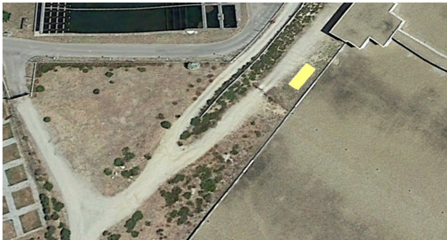
Figura 5.- Situación de bloque de potencia.
