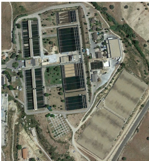
Figura 2-1 Vista de ETAP de Colmenar y deposito Pinar.
