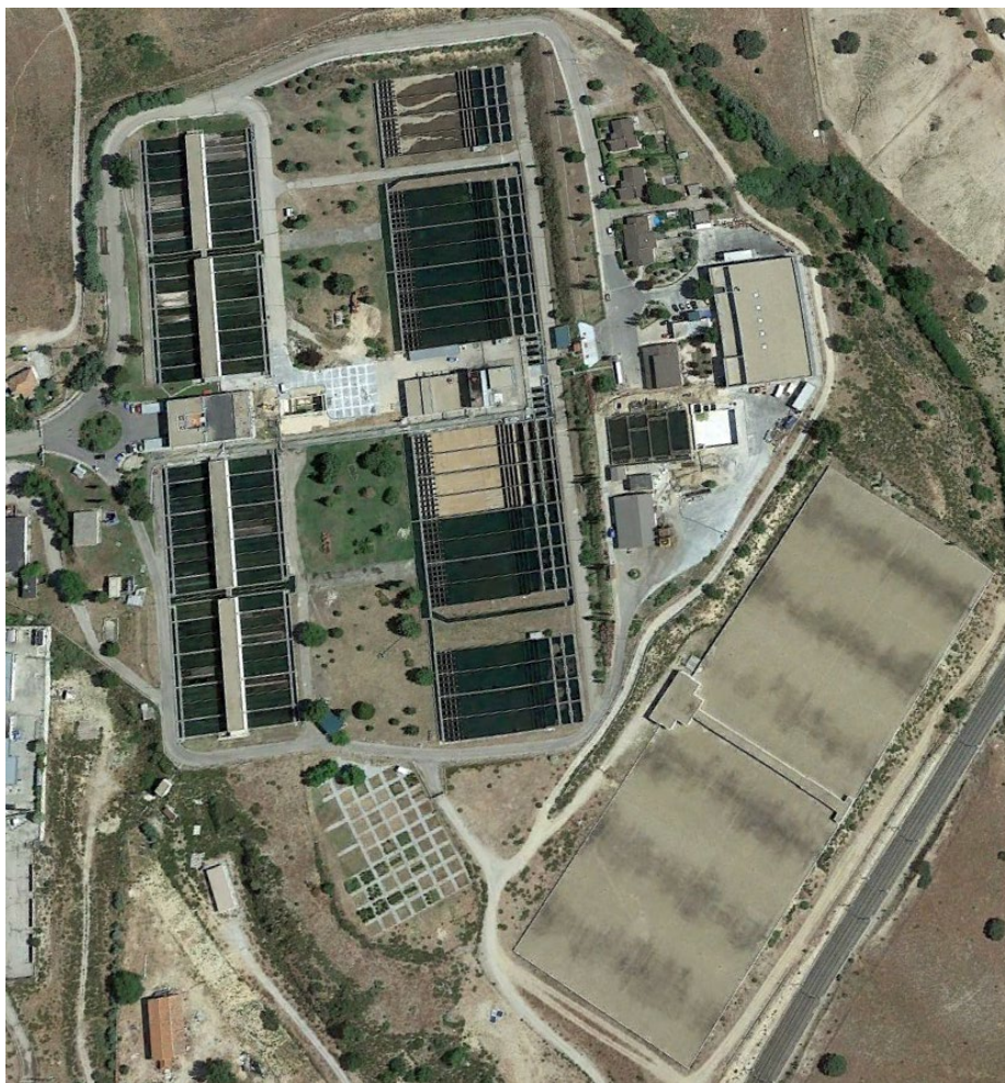
Figura 2-1 Vista de ETAP de Colmenar y deposito Pinar.
