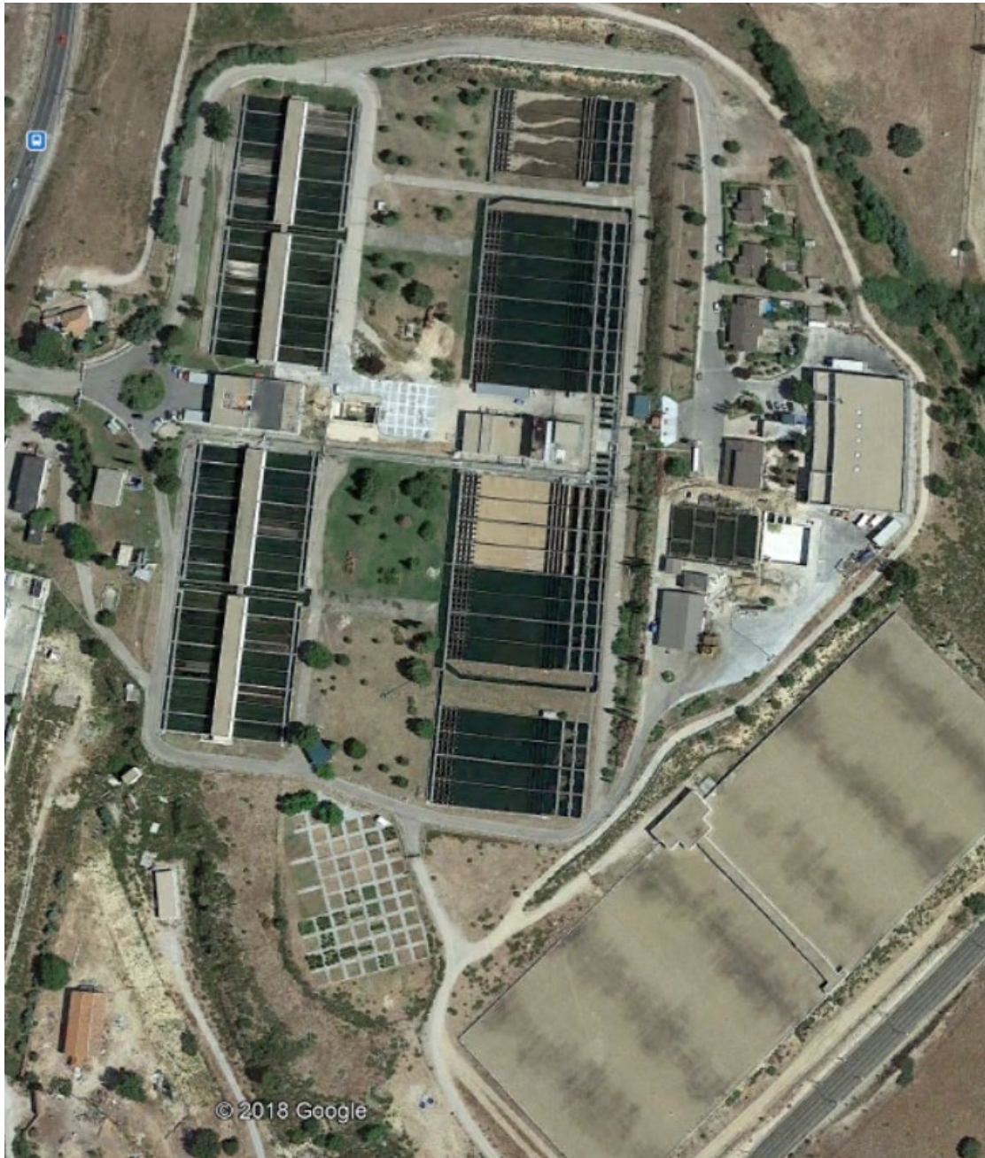
Figura 1.- Vista General ETAP Colmenar
