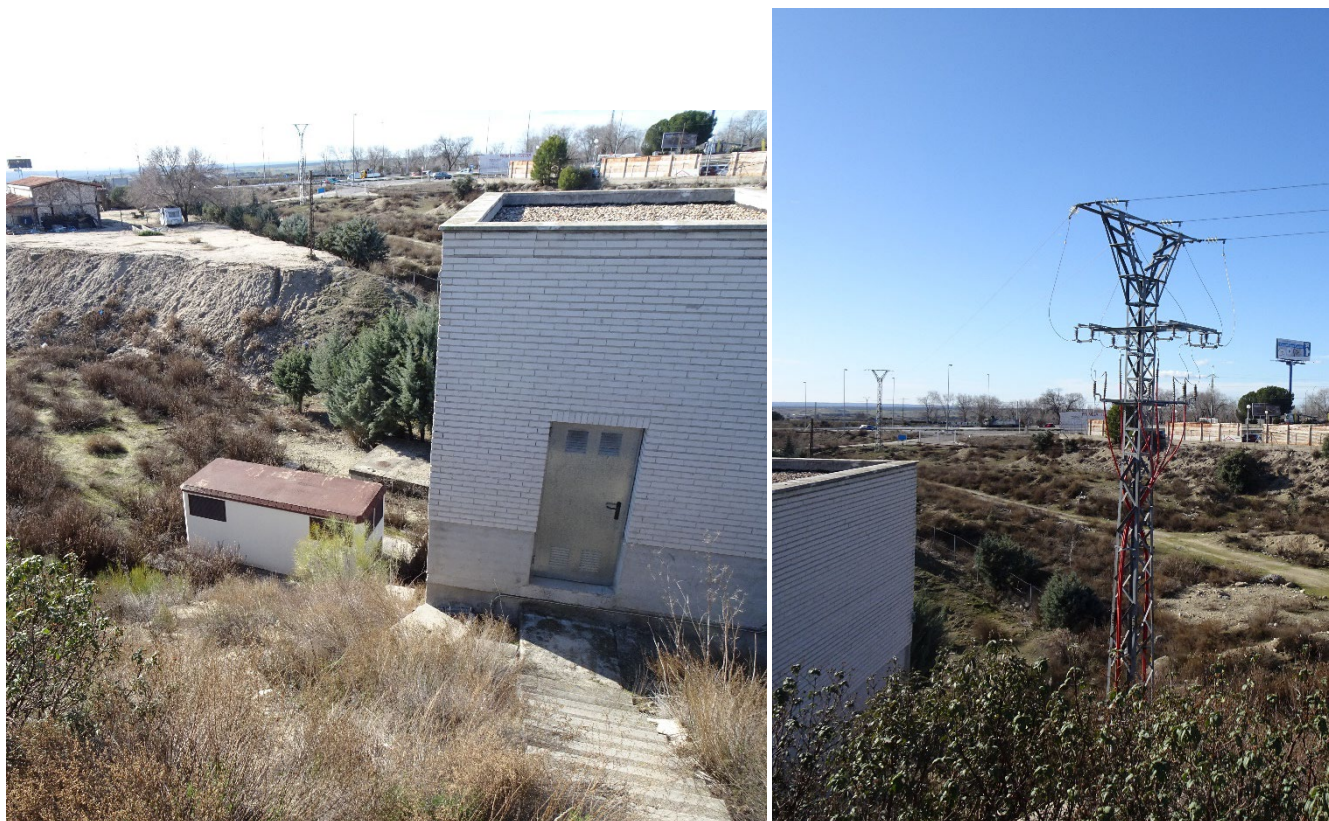
Figura 6. Vista de la estación elevadora Nuevo Tres Cantos
