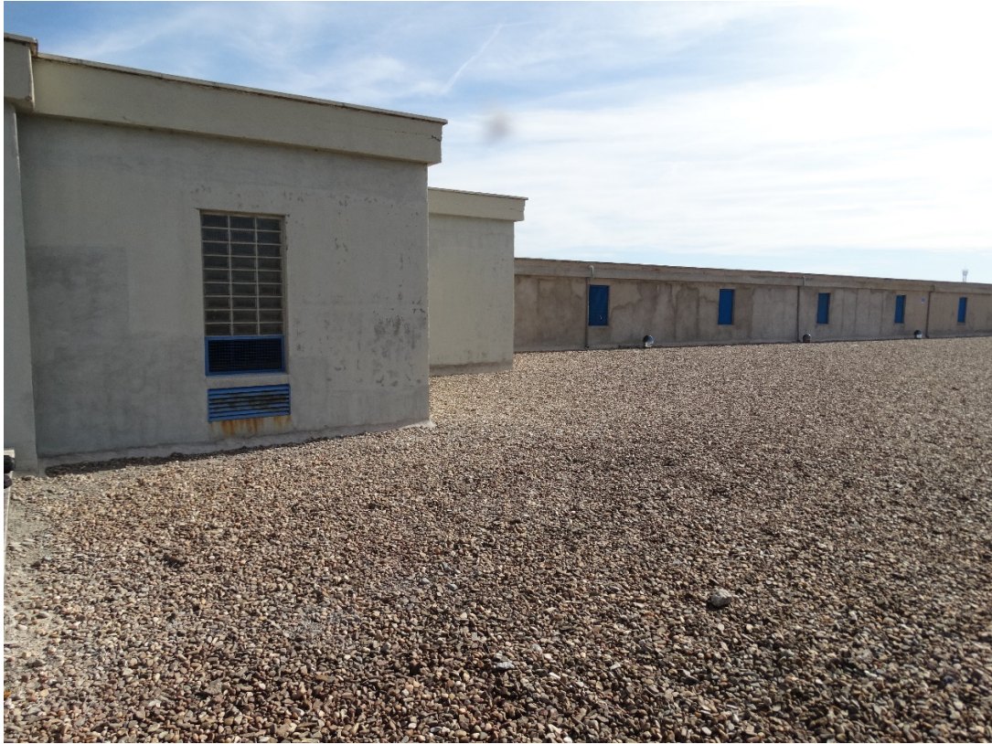
Imagen 2-6. Vista general de la caseta de válvulas y la galería que divide la cubierta.
