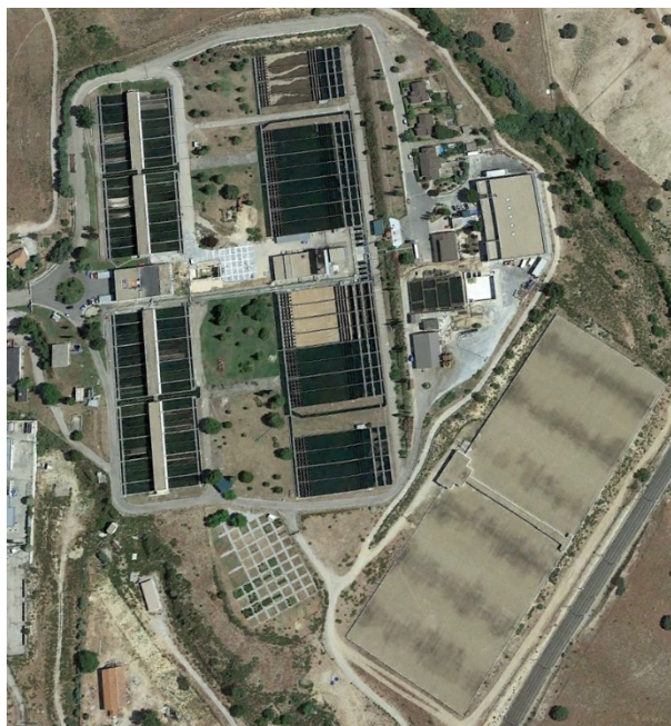
Figura 2-1 Vista de la ETAP y el depósito de Colmenar
