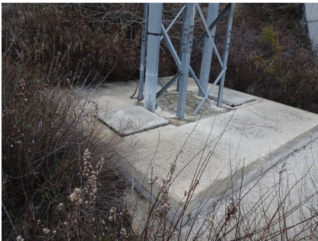
Imagen 5-5. Vista de cimentación del apoyo con las arquetas de las dos derivaciones para hacer anillo con el CT de Nuevo Tres Cantos.
