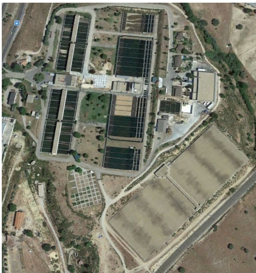
Figura 3. Vista aérea de ETAP de Colmenar y deposito El Pinar.
