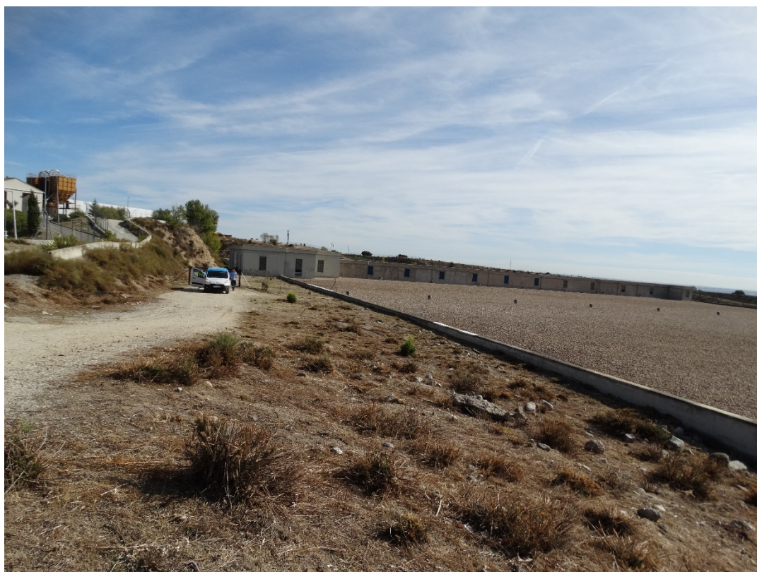
Imagen 2-1. Vista general de la entrada al depósito.
