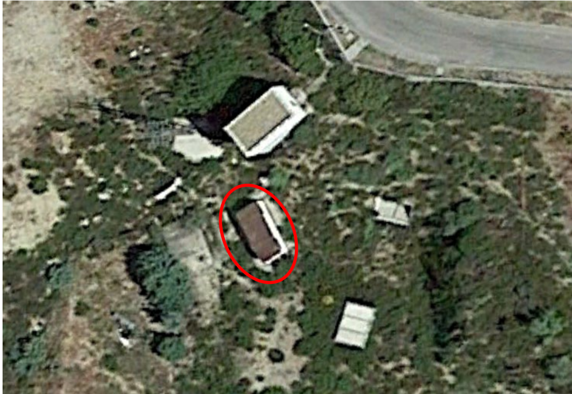
Imagen 5-6. Vista de la Estación Elevadora de Nuevo Tres Cantos en ortofoto.
