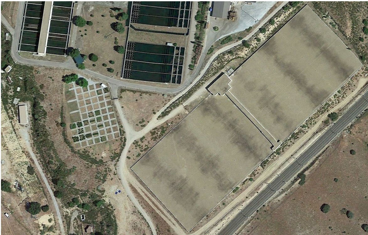
Imagen 1. Vista general aérea de la zona de implantación.
