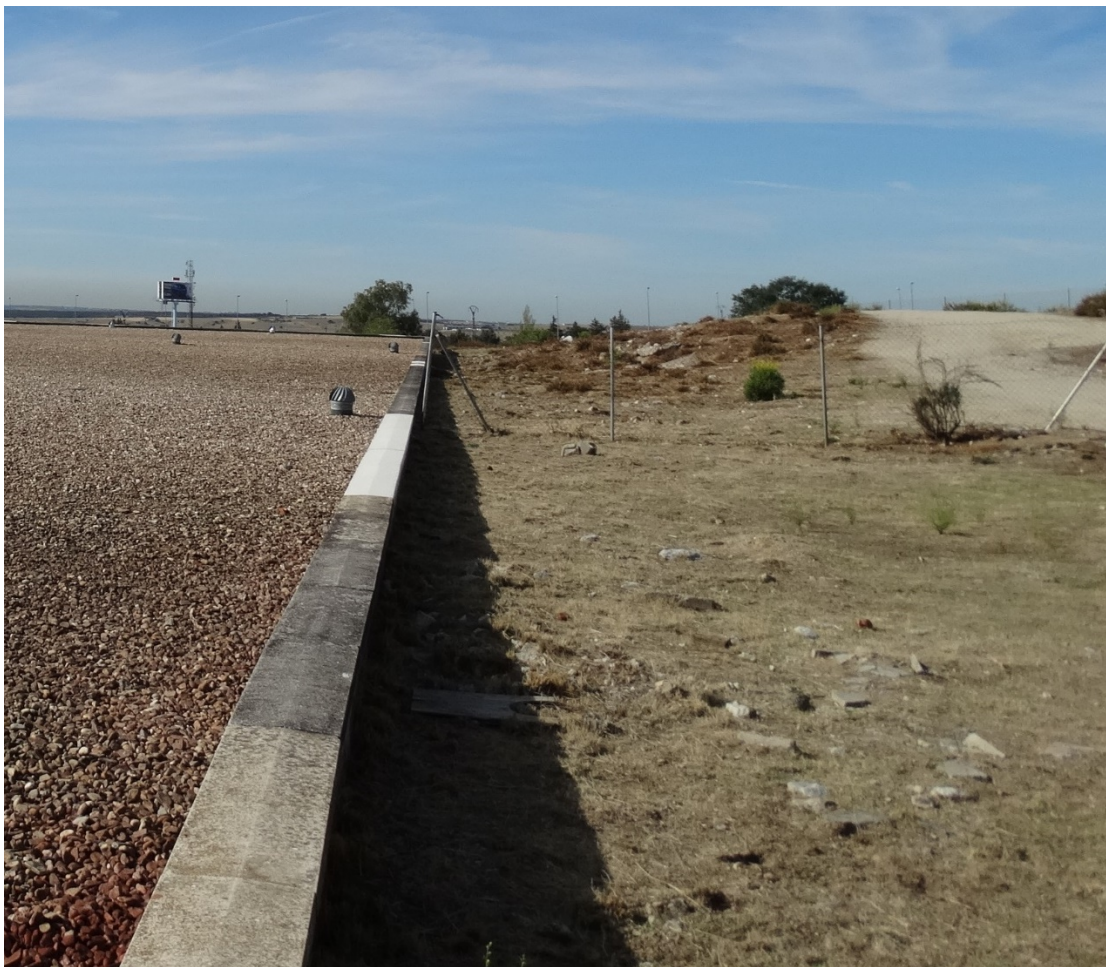
Imagen 3-1. Zona de colocación de centro de transformación cercano a muro NO. Vista dirección Suroeste. Oeste.
