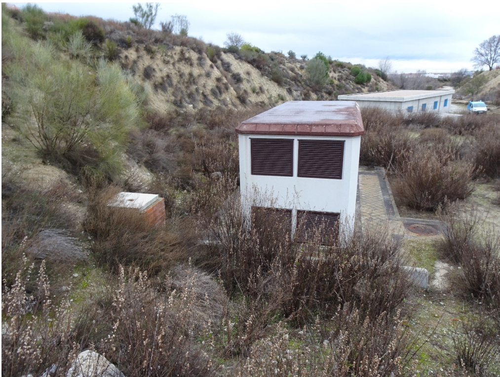
Imagen 5-7. Centro de transformación de Nuevo Tres Cantos.
