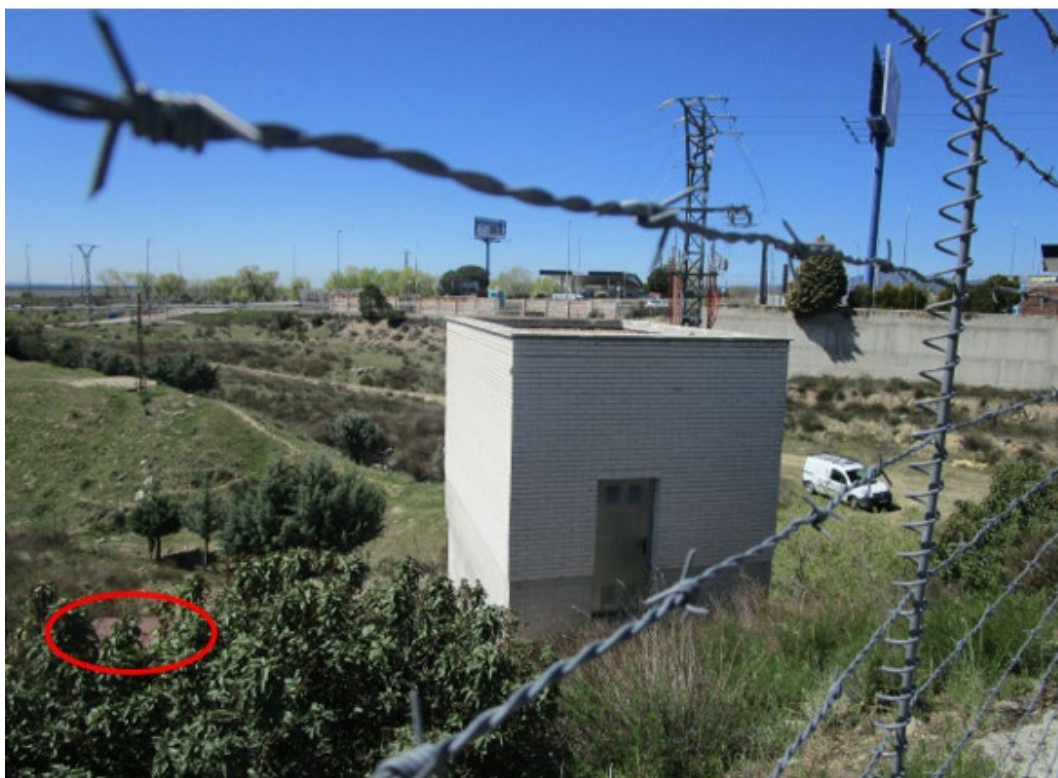
Imagen 5-3. Vista de la Estación Elevadora de Nuevo Tres Cantos desde la ETAP. Punto de giro de la zanja hacia la Estación por el terraplén.
