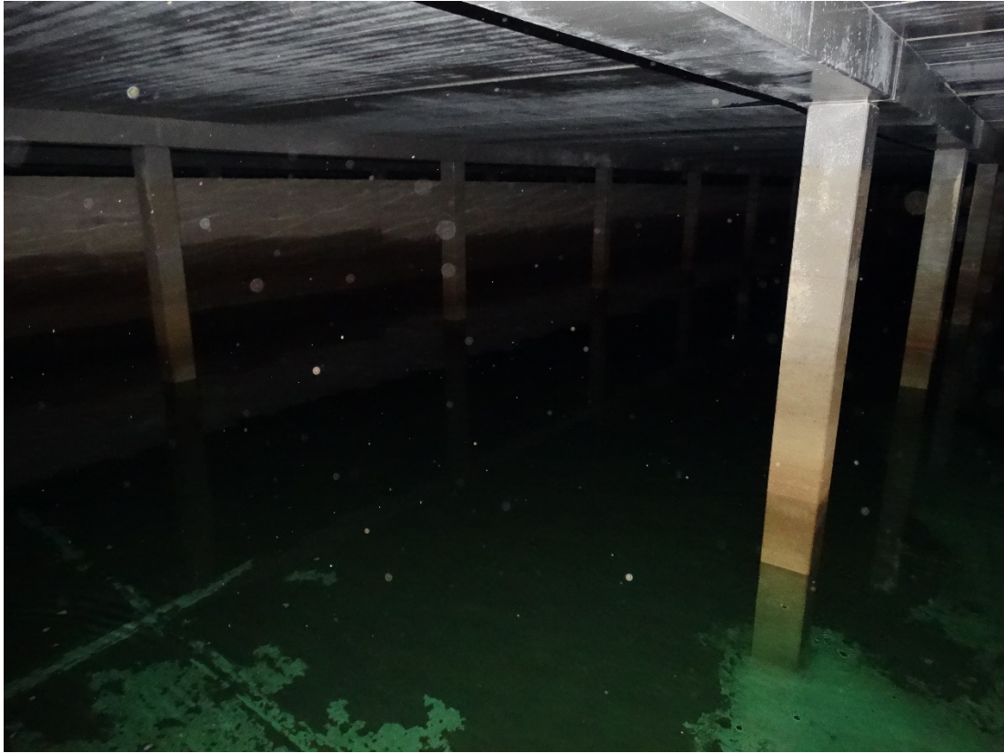
Imagen 2-8. Vista del interior del depósito del Pinar.
