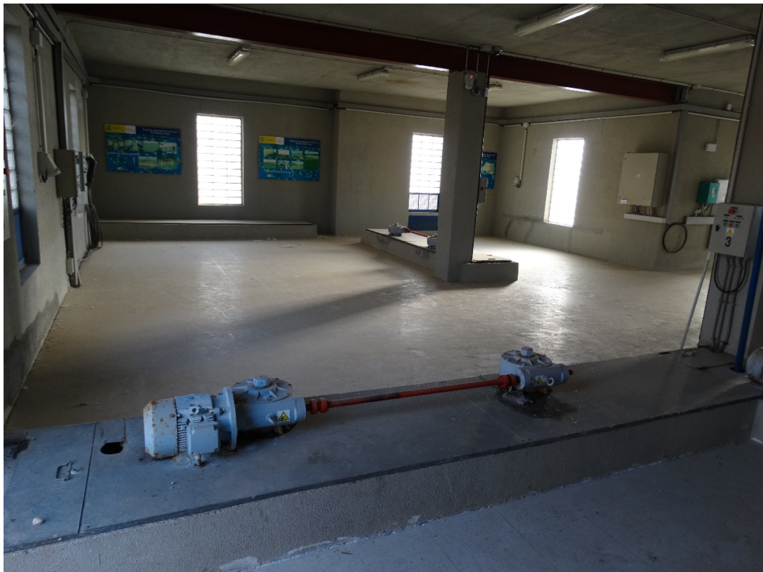
Imagen 2-7. Vista interior de la caseta de válvulas.
