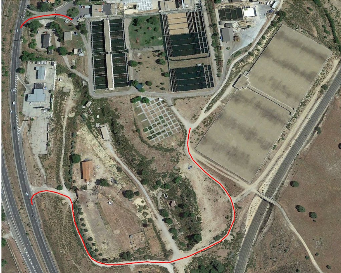
Figura 1. Vista aérea de las dos entradas existentes a la ETAP de Colmenar.
