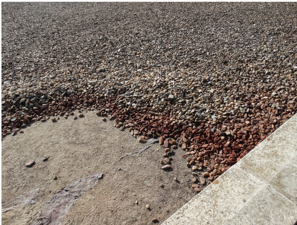
Imagen 2-4. Vista de la cubierta. Se observa el tejido impermeabilizante, y encima una capa protectora de grava. Imagen realizada desde el muro NO de la Planta 1.
