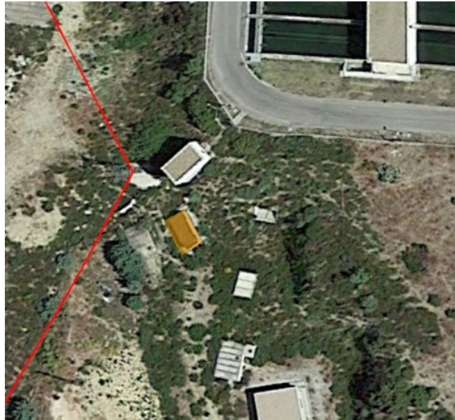
Figura 2.- Vista Estación elevadora Nuevo Tres Cantos
