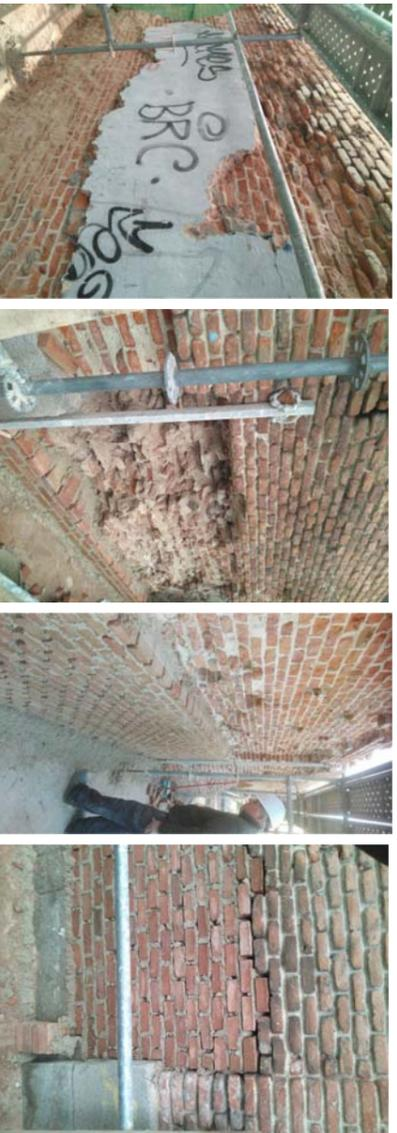
Retirada de mortero de cemento. Su elevada resistencia con respecto al material original provoca fisuras, desprendimientos, falta de transpiración y transmisión de sales solubles. Esta labor se realizará con antelación a las operaciones de limpieza y rejuntado de fábrica.
