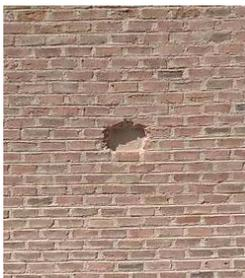
El rejuntado se rehundirá al igual que las juntas de fábrica original, para que el rejuntado actúe como goterón y se acumule el agua entremedias.
