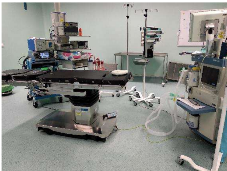
ÁREA MUY CRÍTICA
