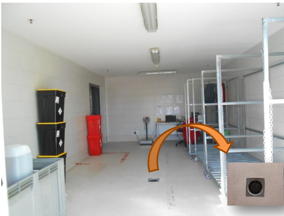
Vista general del depósito final de residuos con desagüe sin tapa. Ver Ítems 110 y 103.
