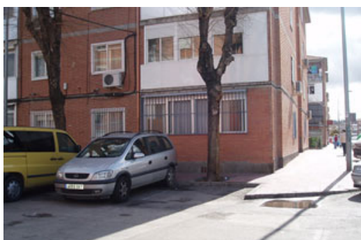
Piso supervisado 3 de Alcalá
