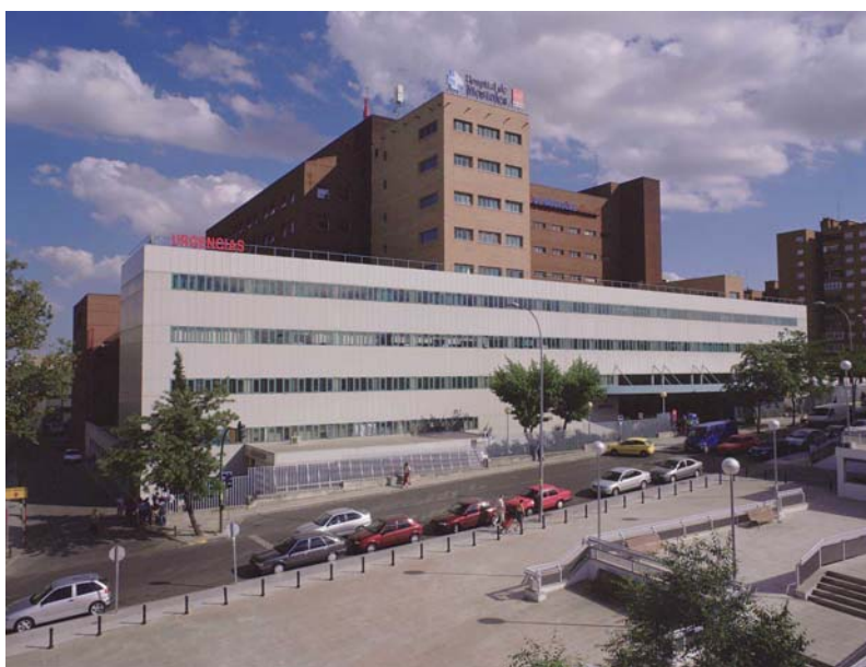
Fachada principal de Hospital Universitario de Móstoles
