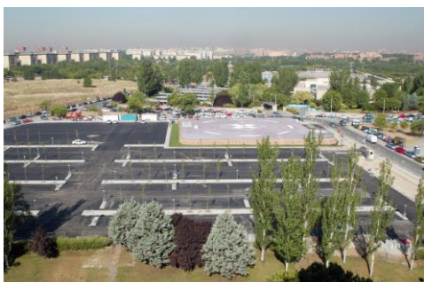
Foto 2: Vista del helipuerto de tierra del Hospital
