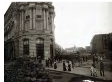
Derribo de casas en 1912 para la apertura de la Gran Vía. A la izquierda, el edificio de Metrópolis ya terminado
