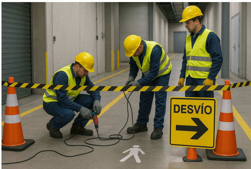
Ilustración 24. Ejemplo de señalización y balizamiento de tareas de mantenimiento con cables que pueden generar caídas al mismo nivel. Fuente: Imagen generada por inteligencia artificial con DALL·E (OpenAI, 2025)
