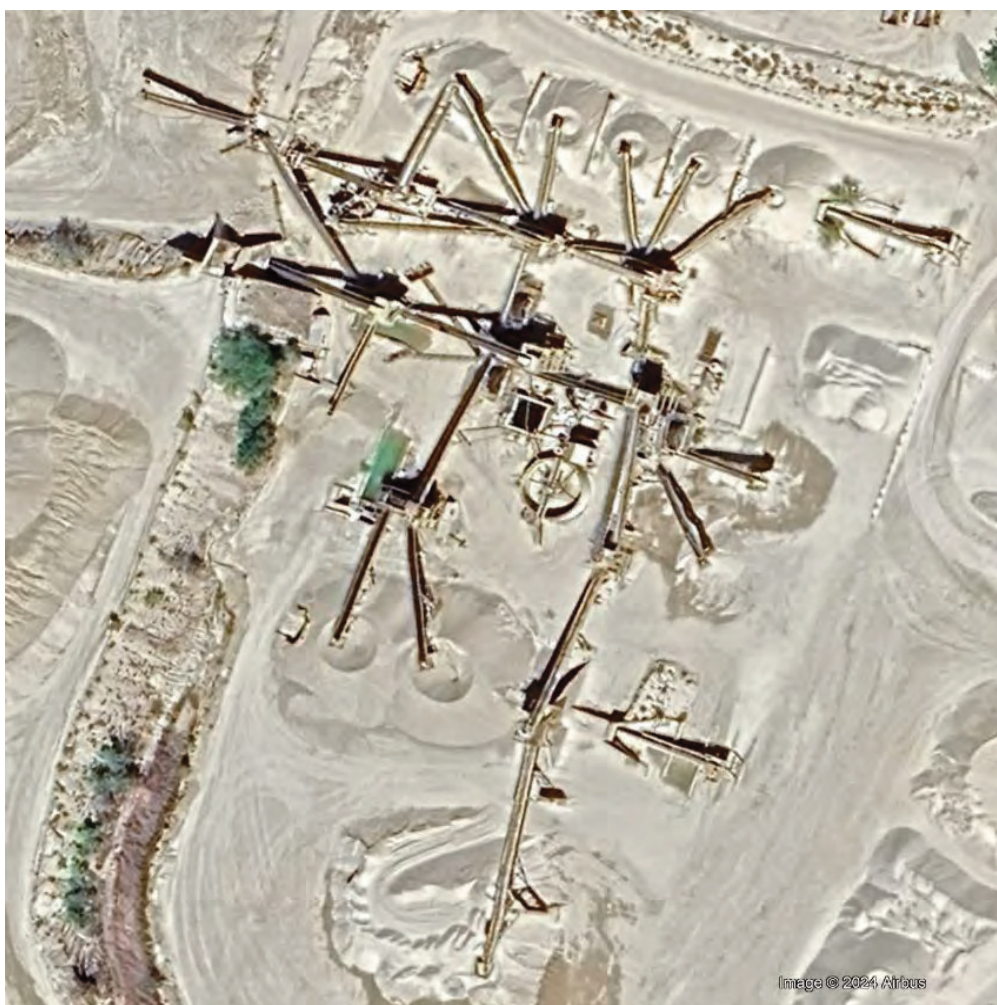
Figura 46. Planta de tratamiento
