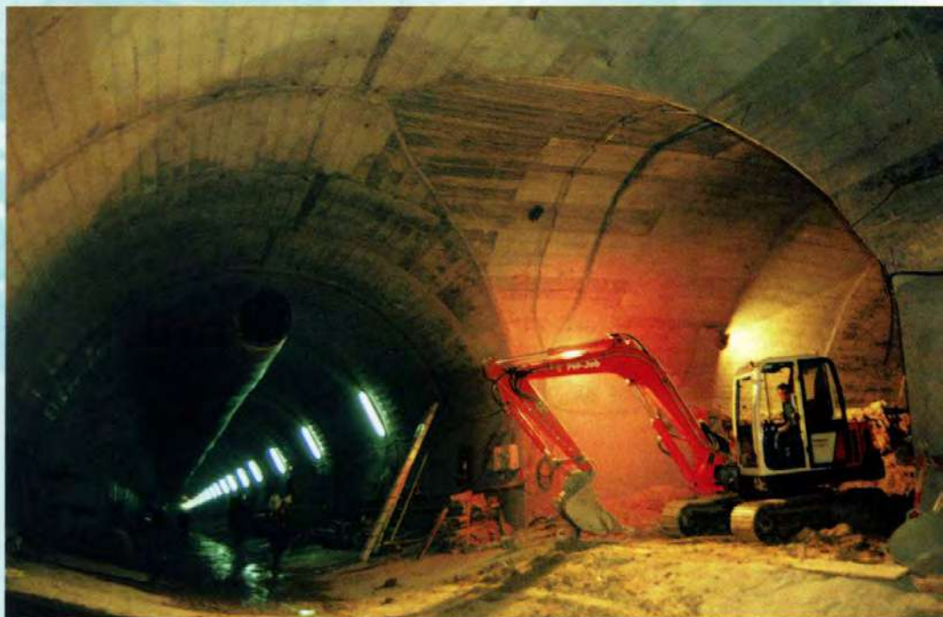
Túnel en mina. Ejecución.
