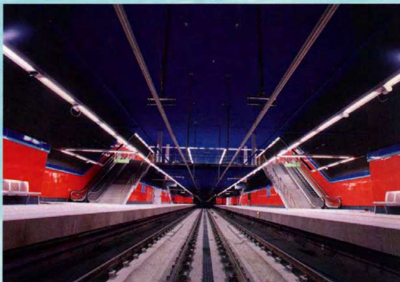
Estación de Congosto.
