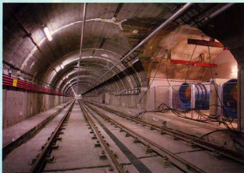
Túnel en mina. Estado final.
