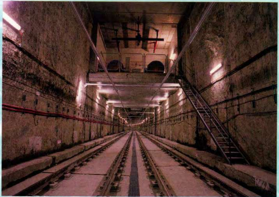
Túnel método a cielo abierto.
