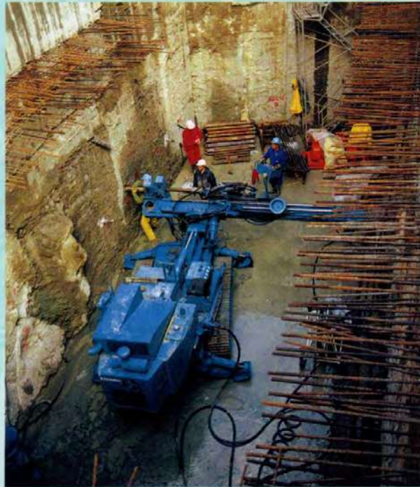
Detalle ejecución de taladros.
