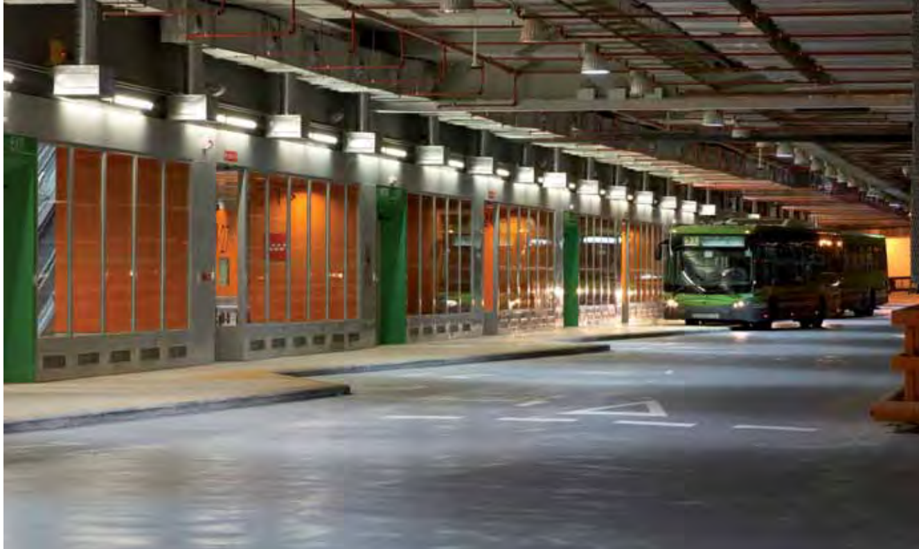
Zona de circulación de autobuses en nivel -2 / Bus manoeuvring area on level -2
