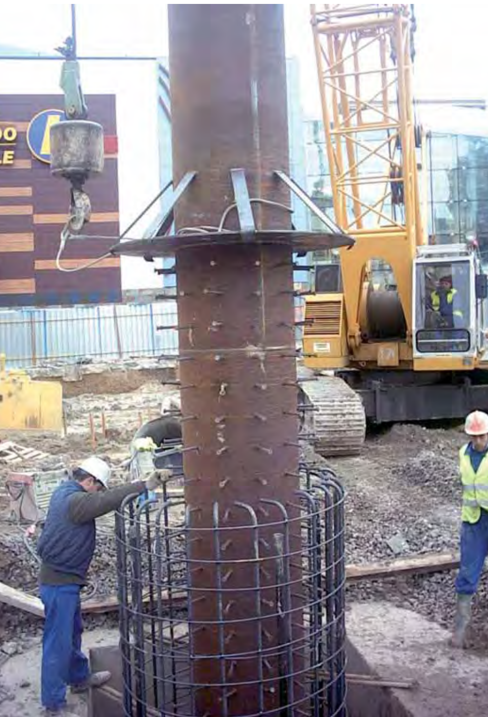
Pila pilote / Pile pier
