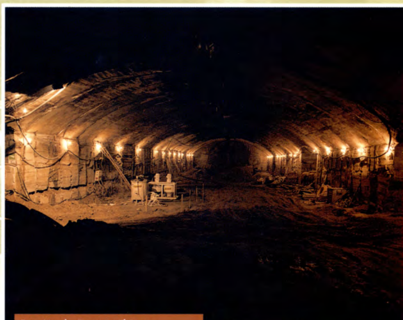
Estación de Guzmán El Bueno. Vista general de la Caverna, Fase 10.
