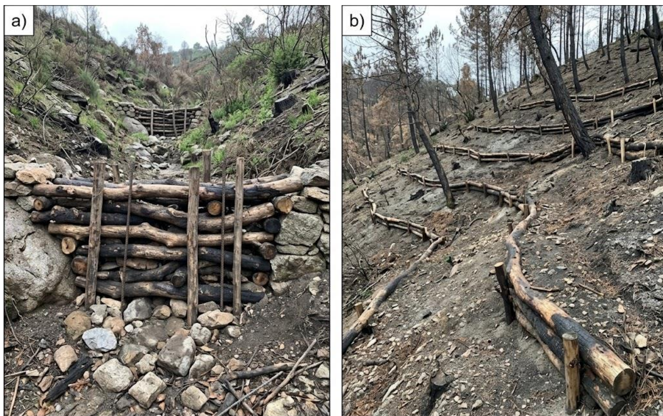
IMAGEN 14. A) DETALLE CONSTRUCTIVO DE ALBARRADA REFORZADA EN VAGUADA TORRENCIAL; B) LADERA TRATADA CON FAJINAS CONSTRUIDAS CON FUSTES DESCORTEZADOS, DISPUESTAS SEGÚN CURVAS DE NIVEL
