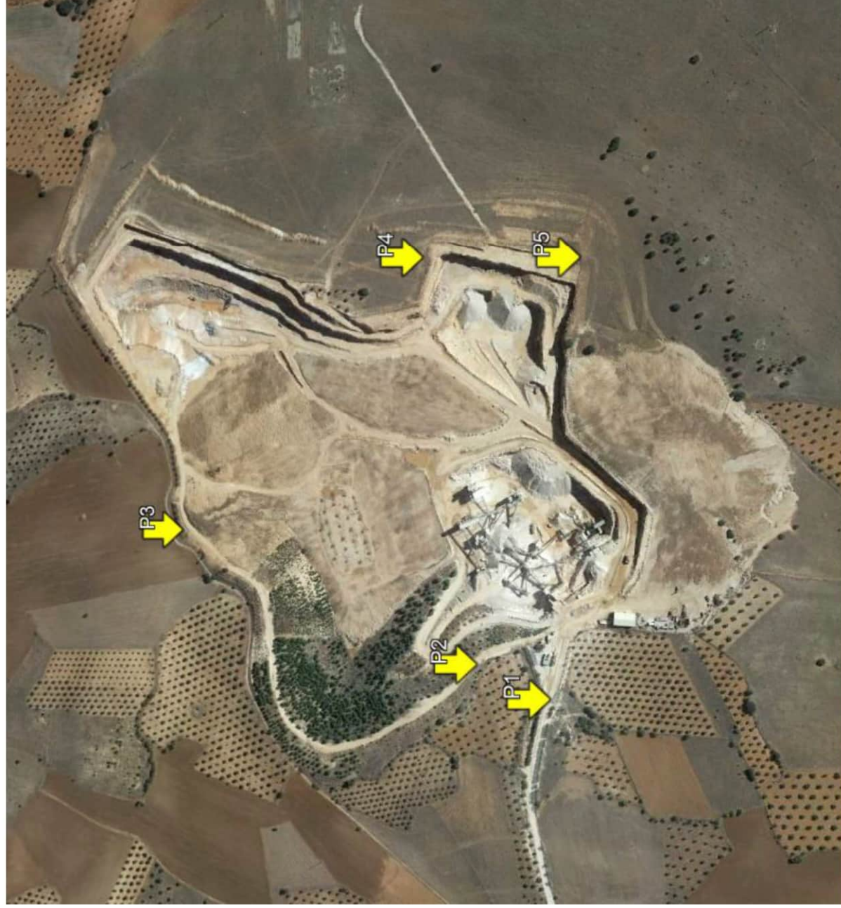
Figura 4.- Imagen área de los puntos de evaluación del perímetro de las instalaciones.
