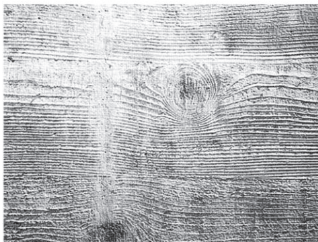
Manzoni, Huella del pulgar izquierdo 1960. Aspecto del hormigón con encofrado de madera. Archivo Fundación Miguel Fisac.
