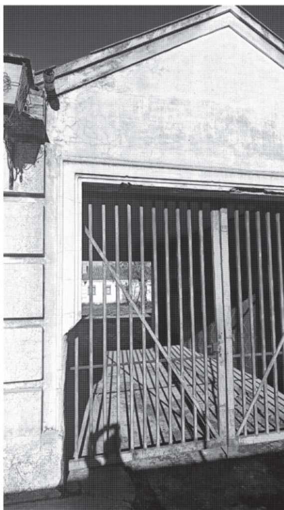
Fotografía 2: Entrada al parador. Foto: Ambrosio Sánchez de Ribera Pecci.
