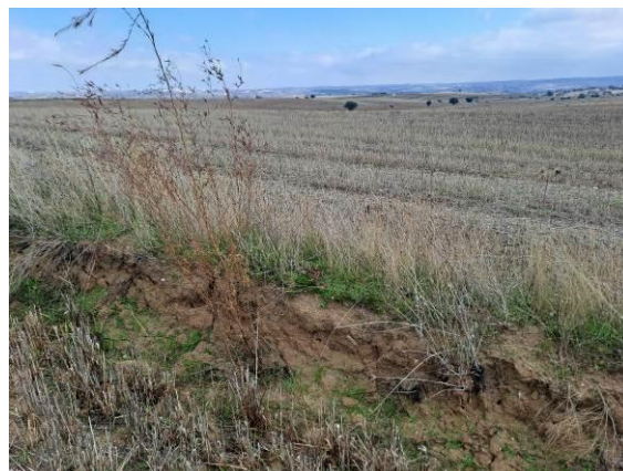
Foto 50. LE soterrada entre Camino del Molino.
