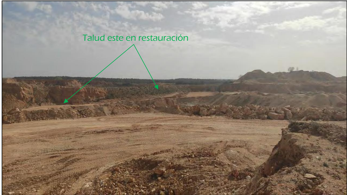
Foto 3.- Vista en dirección sureste de trabajos de relleno y conformado talud este. (480944E/4461517N)
