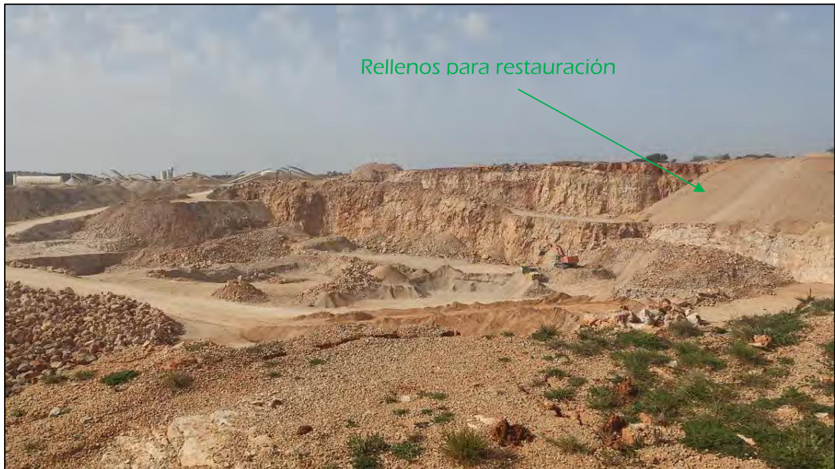
Foto 4.- Rellenos para restauración de taludes en sector oeste del frente norte. (481184E/4461811N)
