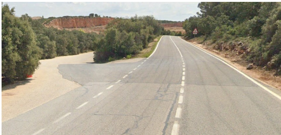
Figura 2. A la izquierda, camino de acceso a la cantera "Monte Orusco" A-396
