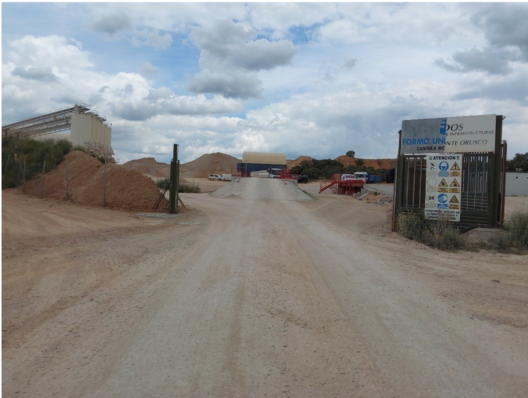
Figura 12. Acceso principal a la cantera
