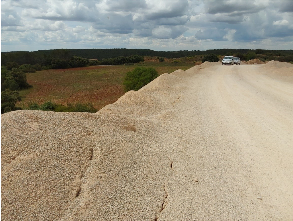
Figura 13. Caminos y pistas dentro de la instalación
