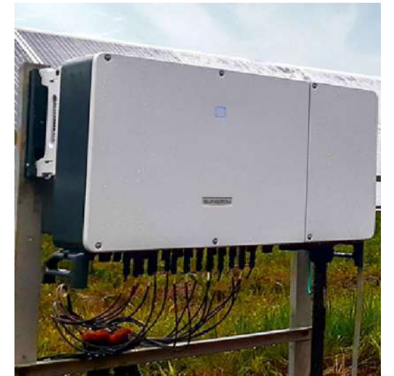
Fuente: Datos del fabricante Nota: Hasta el comienzo de la construcción no estará definida la configuración final de instalación.
