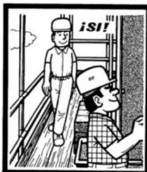
Mantener los puestos de trabajo en orden, los materiales ordenados, la circulación despejada, así se evitarán los resbalones y las caídas.
