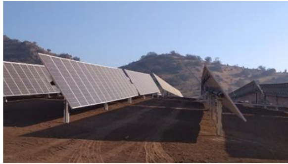
Figura 7. Seguidores monofila (Fuente: Proyecto Técnico Administrativo para AAP de la PSFV "Las Colinas")
