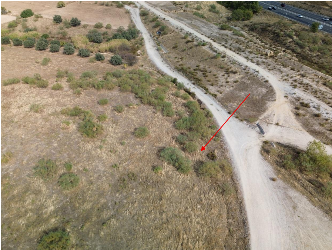
Figura 86. Terreno de implantación del apoyo AP-9. Ubicación señalizada con flecha roja. Fotografía tomada con dron el día 28 de octubre de 2025.
