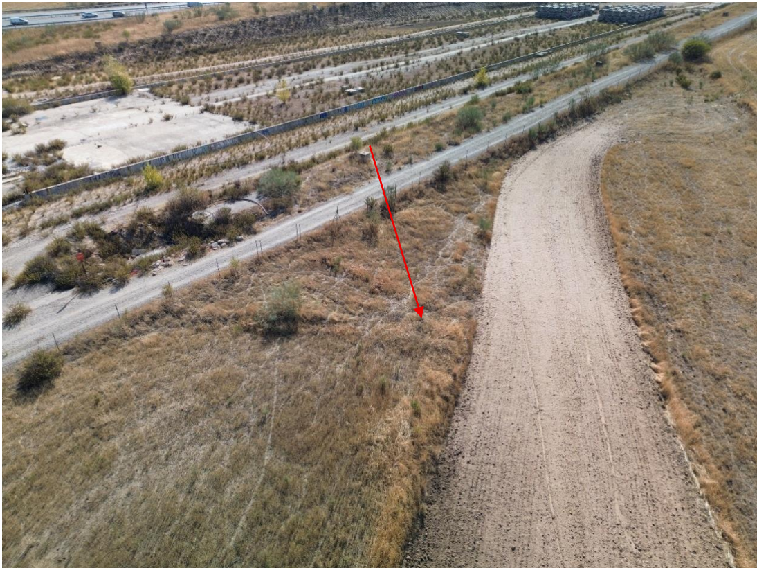
Figura 84. Terreno de implantación del apoyo AP-11. Ubicación señalizada con flecha roja. Fotografía tomada con dron el día 28 de octubre de 2025.
