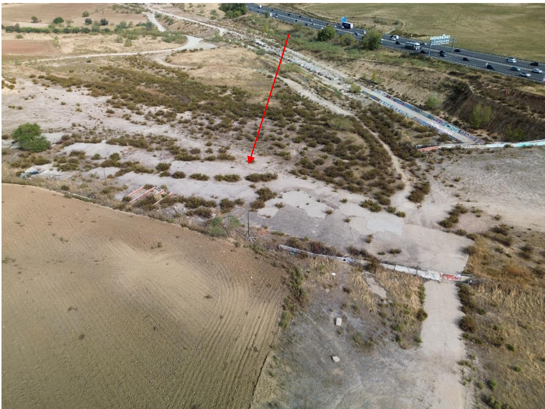
Figura 87. Terreno de implantación del apoyo AP-8. Ubicación señalizada con flecha roja. Fotografía tomada con dron el día 28 de octubre de 2025.
