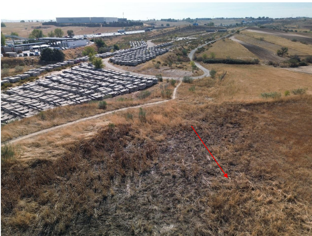
Figura 82. Terreno de implantación del apoyo AP-12. Ubicación señalizada con flecha roja. Fotografía tomada con dron el día 28 de octubre de 2025.
