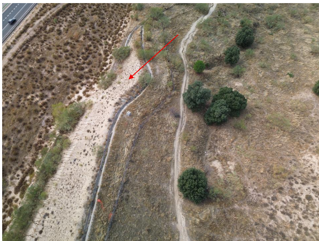
Figura 95. Terreno de implantación del apoyo AP-2. Ubicación señalizada con flecha roja. Fotografía tomada con dron el día 28 de octubre de 2025.
