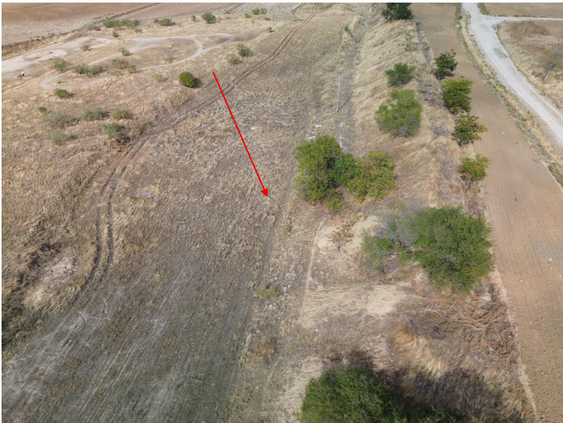
Figura 90. Terreno de implantación del apoyo AP-6. Ubicación señalizada con flecha roja. Fotografía tomada con dron el día 28 de octubre de 2025.
