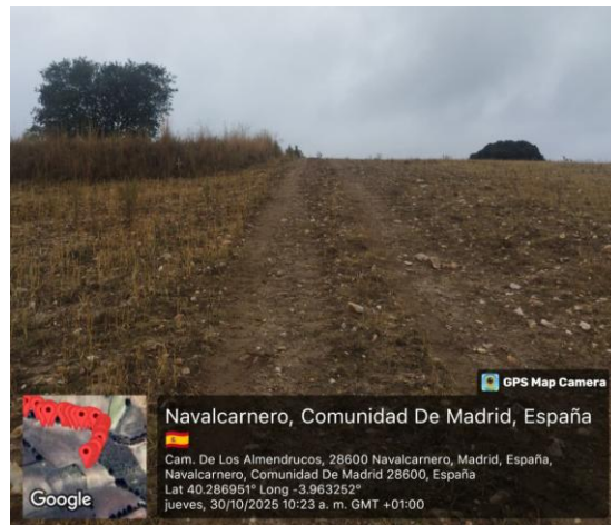
Figura 137. Continuación del tramo 17 de la zanja. Se observa que discurre por tierras en barbecho. Fotografía tomada el 30 de octubre de 2025.
