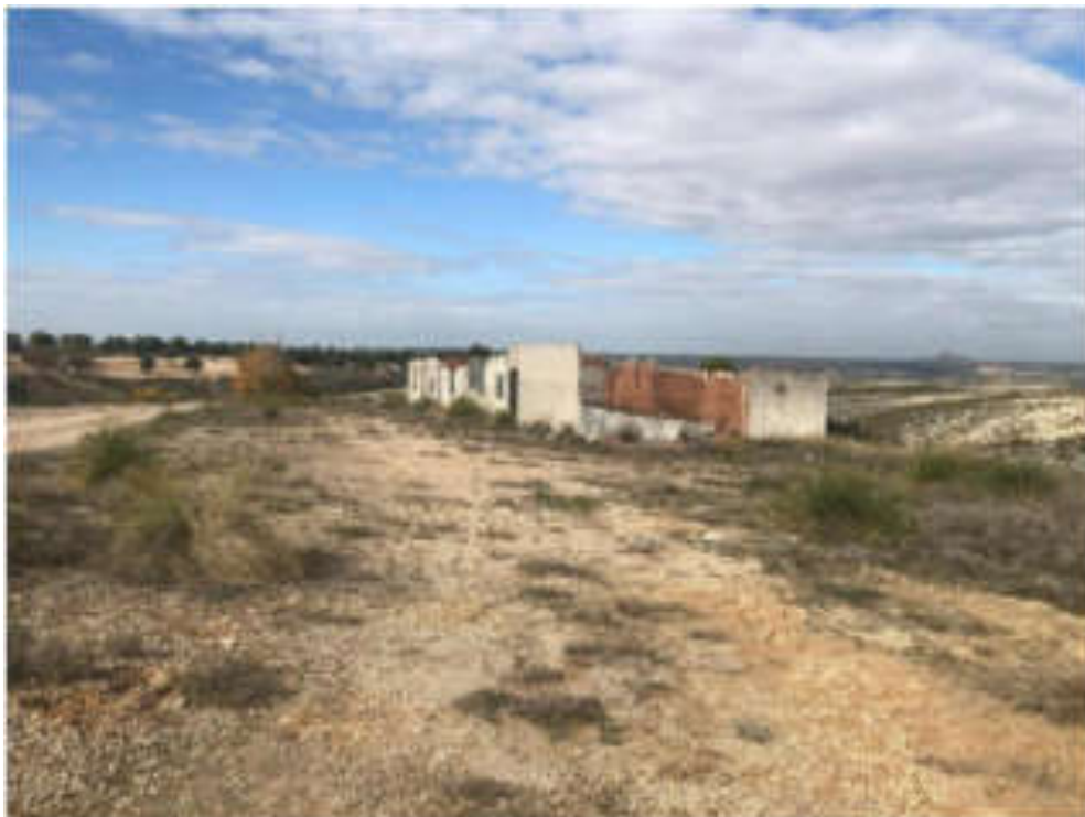
Figura 1.6.- Propiedad abandonada al sur del permiso de investigación, y localización del sondeo nº1
