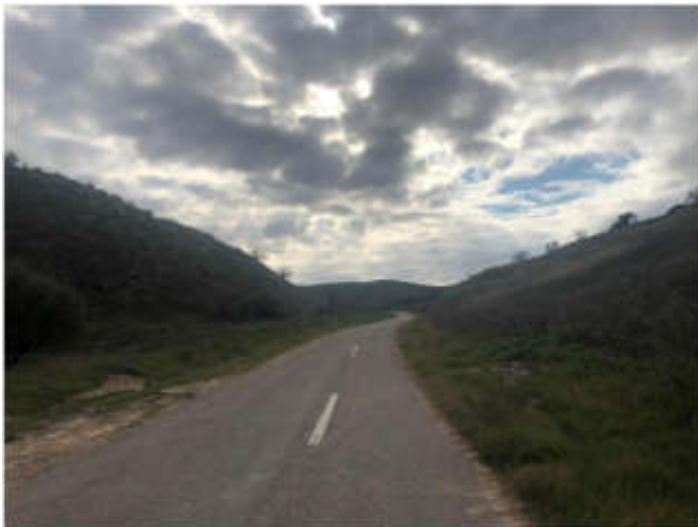
Figura 1.1.- Carretera M-311 a su paso por el sur del Permiso de Investigación de Aviñón
