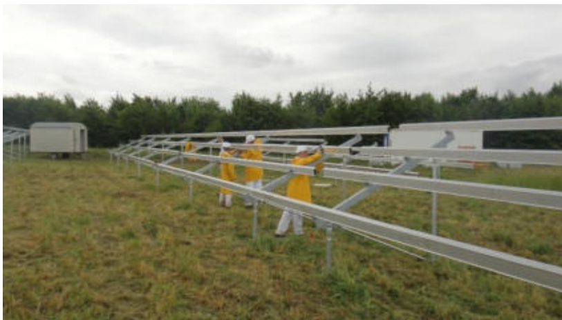
Imagen 16 Montaje de estructura fija con perfiles hincados directamente en el terreno
