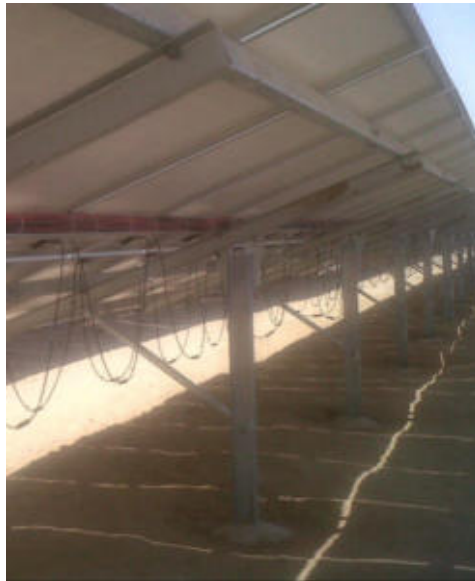
Imagen 14 Cimentación con micro pilote. Detalle de cimentación y acabado
