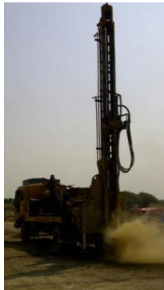
Imagen 15 Detalle de hincado de perfiles con maquinaria especializada
