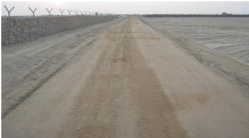
Imagen 10 Detalle de vial tipo en ejecución
