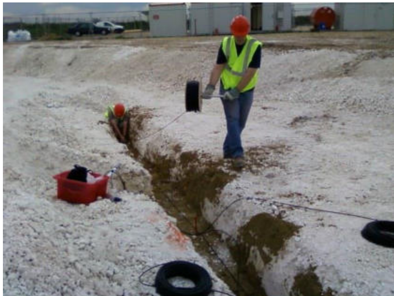
Imagen 17 Tendido de cable en zanja
