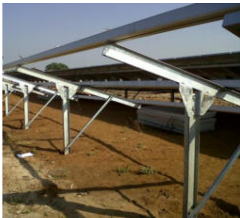
Imagen 13 Perfiles hincados directamente en el terreno
