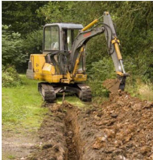
Imagen 12 Excavación de zanjas
