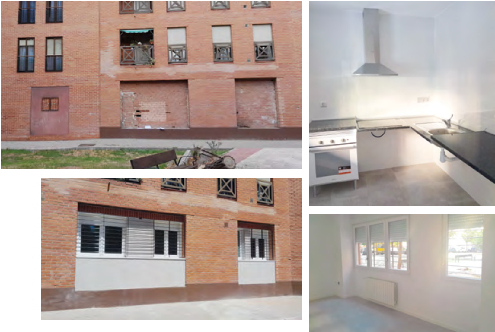
Transformacion local comercial en vivienda social adaptada. San Blas
