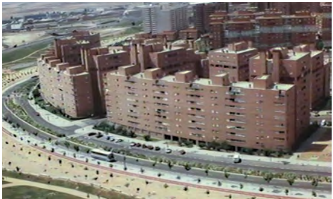
Palomeras antes de la remodelación y después
