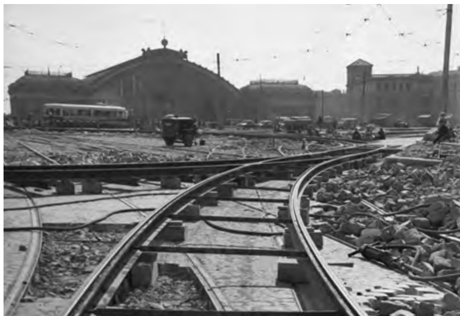
1961. Obras en las vías del tranvía junto a la Estación de Atocha. Fondo fotográfico Martín Santos Yubero. ARCM.
