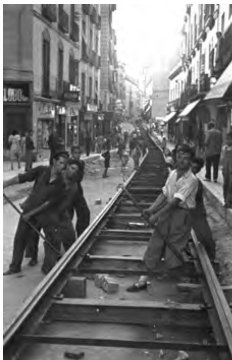
1947. Obras para el tranvía en la calle Magdalena. Fondo fotográfico Martín Santos Yubero. ARCM.
