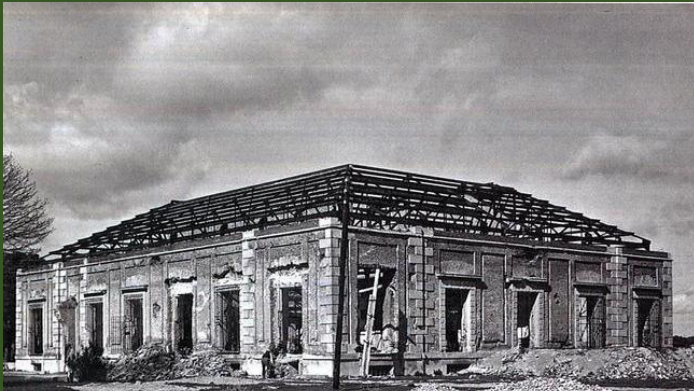
Estado en el que quedó el Palacio de la Zarzuela tras la Guerra Civil.
