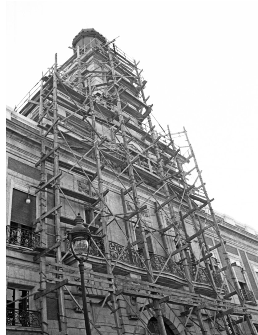
1941. Obras de rehabilitación en la fachada de la Real Casa de Correos, entonces sede del ministerio de la Gobernación. ARCM. Fondo Martín Santos Yubero. Signatura 031584/002.
