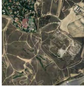
Año 2009. Edificios demolidos
