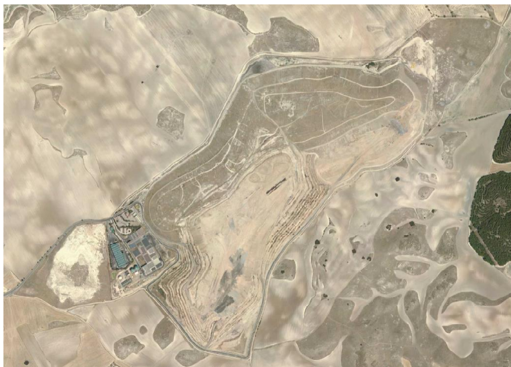
Figura Situación actual del vertedero (Imagen PNOA 2017)
