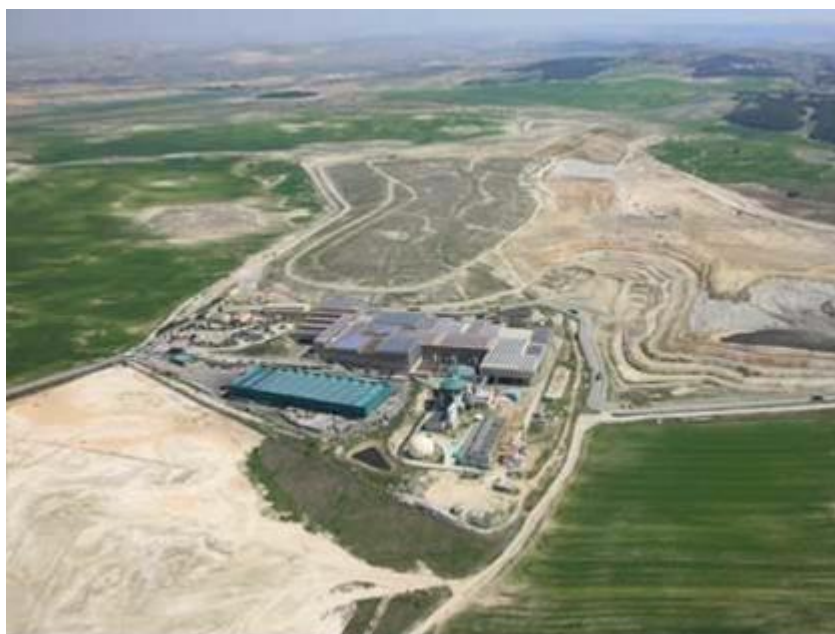
Figura Vista del vertedero desde su extremo suroeste, con la zona de instalaciones y edificaciones en primer término. En segundo plano, las fases clausuradas (a la izquierda) y las celdas en explotación de la Fase III (a la derecha)
