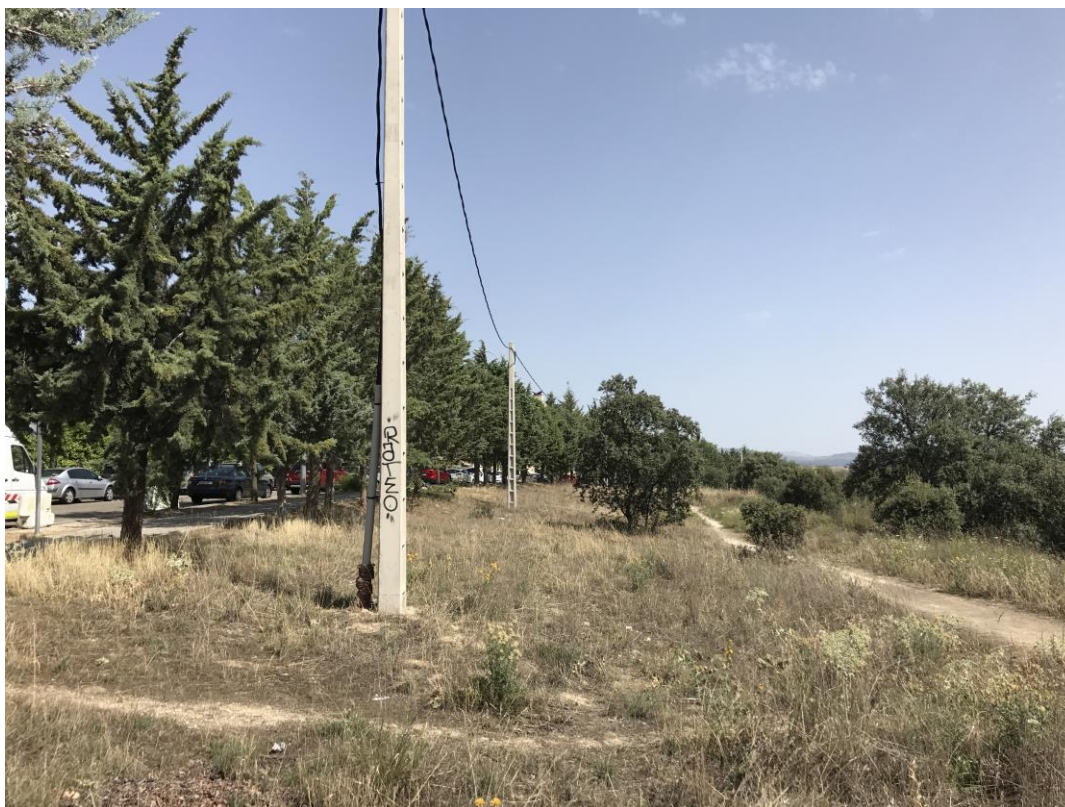
Línea aérea de baja tensión paralela a la Ronda de Valdecarrizo sobre apoyos de hormigón.
