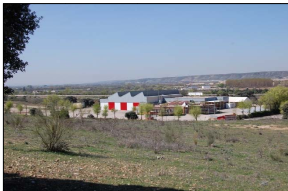
Instalación logística situada entre la avenida de Madrid y el camino de los Depósitos.
