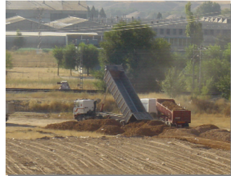
Acopios de tierra vegetal para su reutilización
