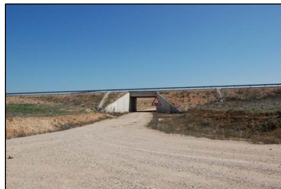
Vista de uno de los pasos inferiores de la carretera M-305 que divide el Sector en la zona más septentrional.
