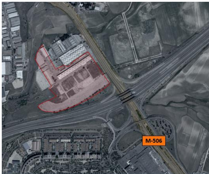
Figura 4. Vista aérea M-506
