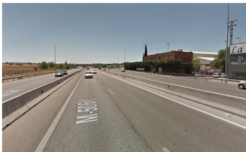
Figura 5. Vista desde M-506 en el tramo de estudio
