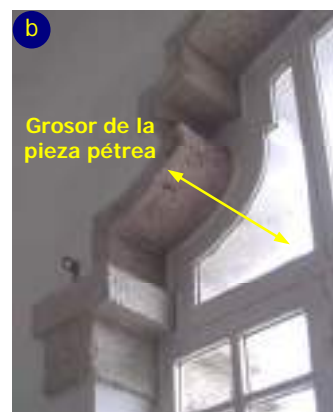
Fig.3.11. Aspecto de los paramentos interiores.
