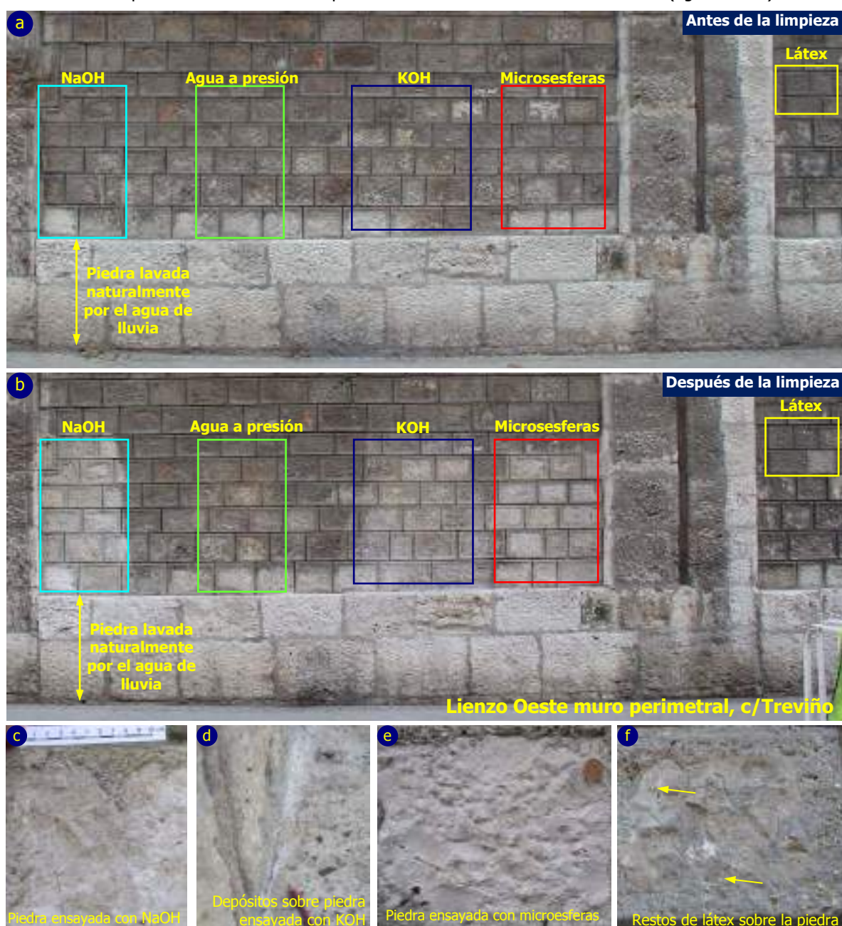
Fig.11.2. Análisis visual de las zonas donde se han ensayado in situ los cinco métodos de limpieza, antes y después de su aplicación, y detalle tras la limpieza de las superficies limpiadas.
