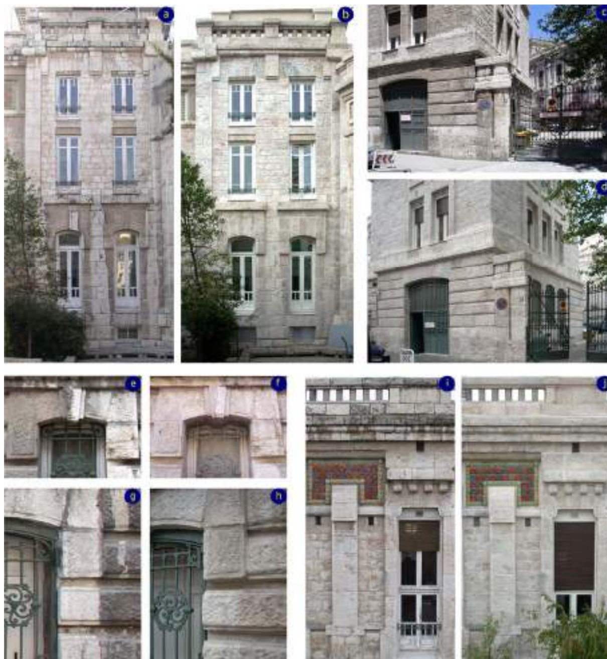
Fig.12.3. Comparativa en la distribución o patrones de color antes (2006) y después (2008) de la limpieza.
