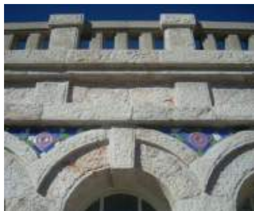
Paneles cerámicos de la fachada Sureste de la nave Noreste (izda.) en el año 2006, puestos en obra en los años 80, y estado del mosaico de azulejos original que reviste las enjutas del torreón exterior en la nave Noroeste (dcha.) en el año 2008, restaurado en la intervención tanto de 1984-1986 como la acometida entre 2006-2008.
