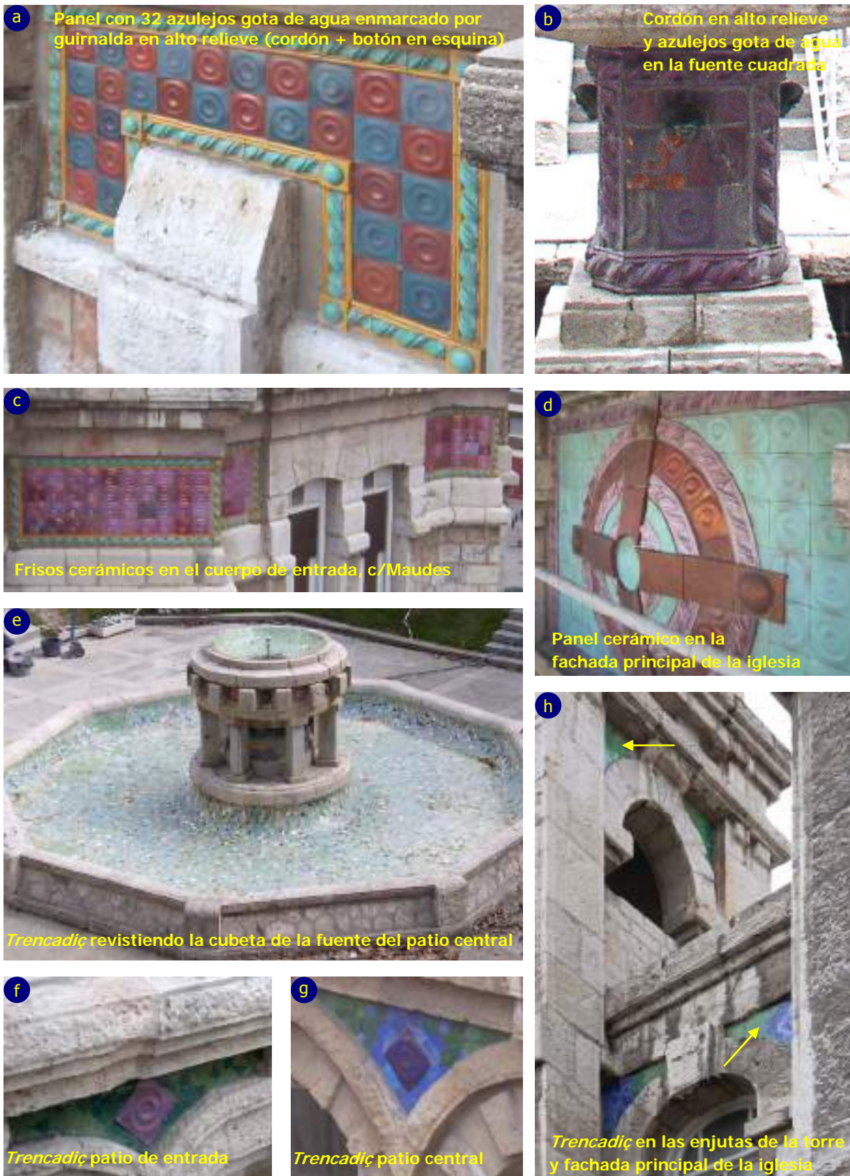
Fig.5.1. Aspecto entre los años 2006 y 2008 de los paneles cerámicos y mosaico de azulejos o trencadiç utilizados para la decoración de las fachadas del Antiguo Hospital.
