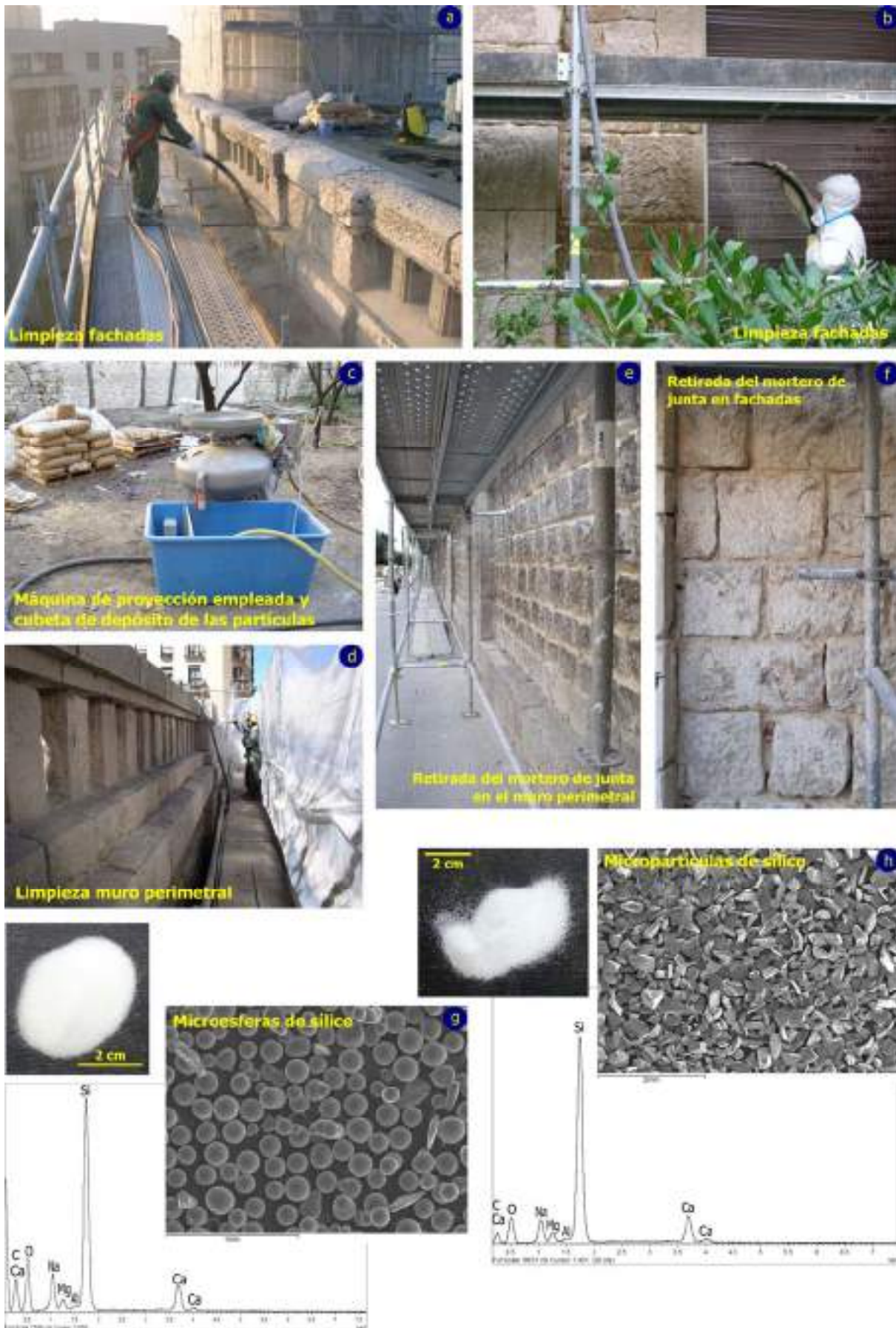
Fig.12.1. Limpieza mediante proyección de partículas en los paramentos del Antiguo Hospital entre 2006 y 2008. Diversos aspectos relativos al método de limpieza empleado, retirada de los morteros de junta antes de la limpieza y aspecto de visu y caracterización mediante MEB-EDS de las partículas proyectadas (microesferas y micropartículas de sílice).
