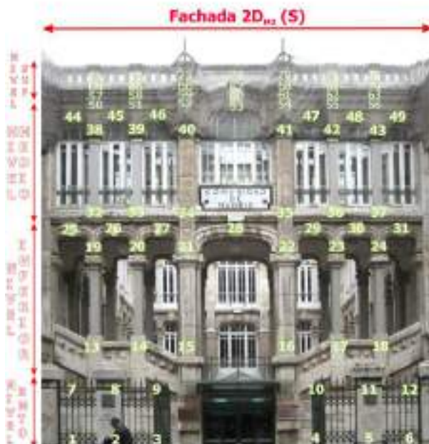
Fig. 3. Retícula establecida en el cuerpo central de la fachada de acceso al inmueble por la calle Maudes (2D M2 ). Año 2006, antes limpieza.
