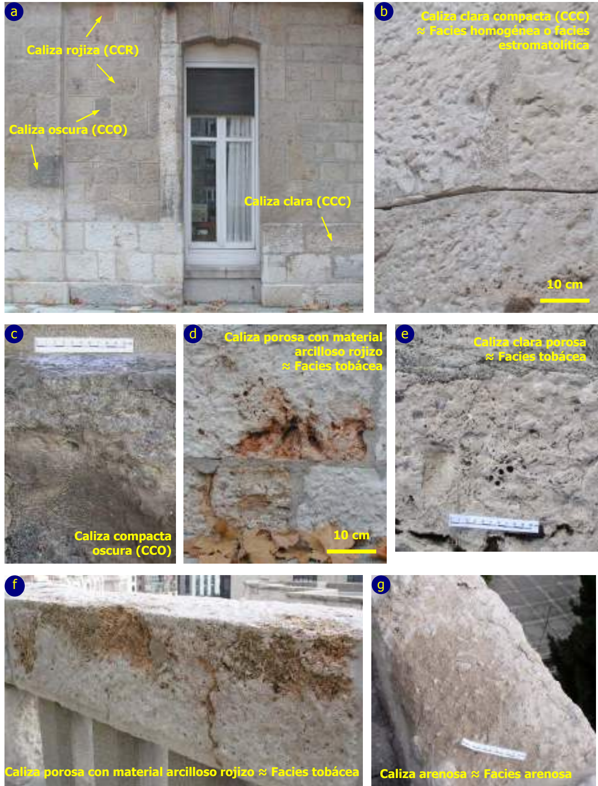
Fig.4.3. Principales variedades de piedra caliza identificadas en las fachadas del Antiguo Hospital y su posible correspondencia con algunas de las facies de los carbonatos fluviolacustres de la Unidad Superior Miocena de la cuenca terciaria continental de Madrid (año 2006).
