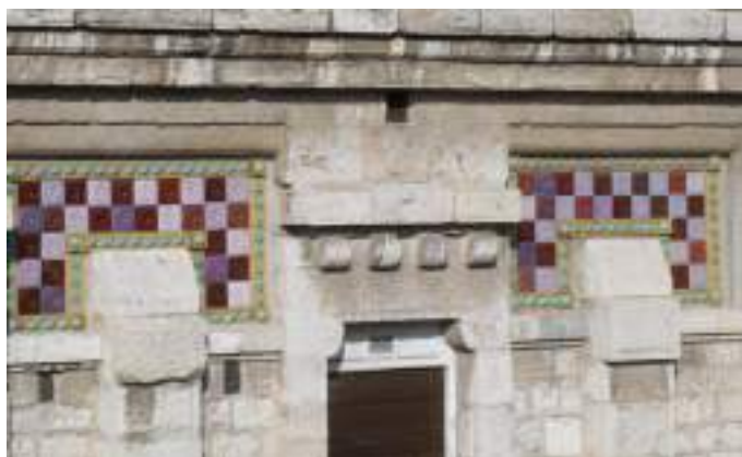
Paneles cerámicos de la fachada Sureste de la nave Noreste (izda.) en el año 2006, puestos en obra en los años 80, y estado del mosaico de azulejos original que reviste las enjutas del torreón exterior en la nave Noroeste (dcha.) en el año 2008, restaurado en la intervención tanto de 1984-1986 como la acometida entre 2006-2008.
