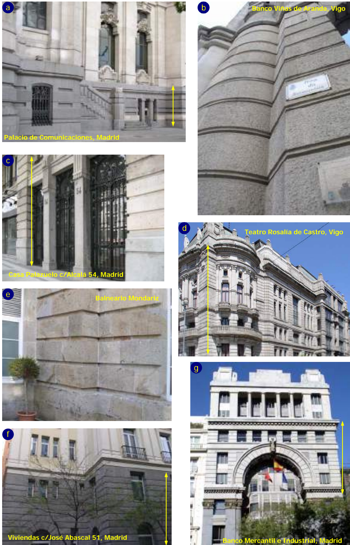
Fig.3.17. Construcciones madrileñas y gallegas de Antonio Palacios cuyos paramentos de cantería presentan juntas rehundidas (zona indicada con flecha amarilla).
