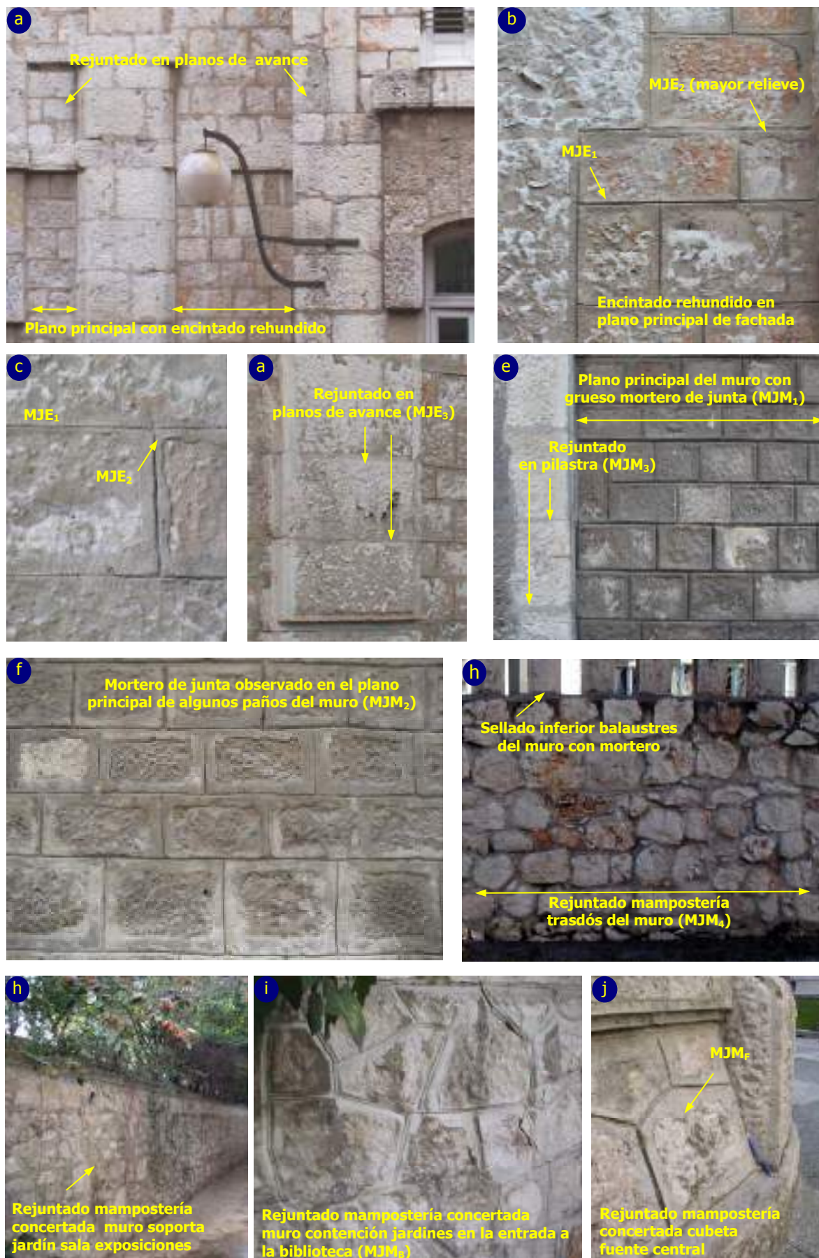
Fig.6.3. Aspecto del mortero de fábrica en los paramentos del Antiguo Hospital, fachadas y muro perimetral (año 2006).
