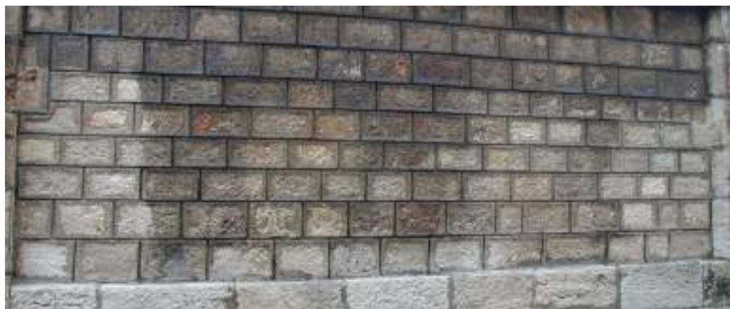
Aspecto de la zona seleccionada en el muro perimetral (c/Treviño) tras el ensayo in situ de los métodos de limpieza evaluados.
