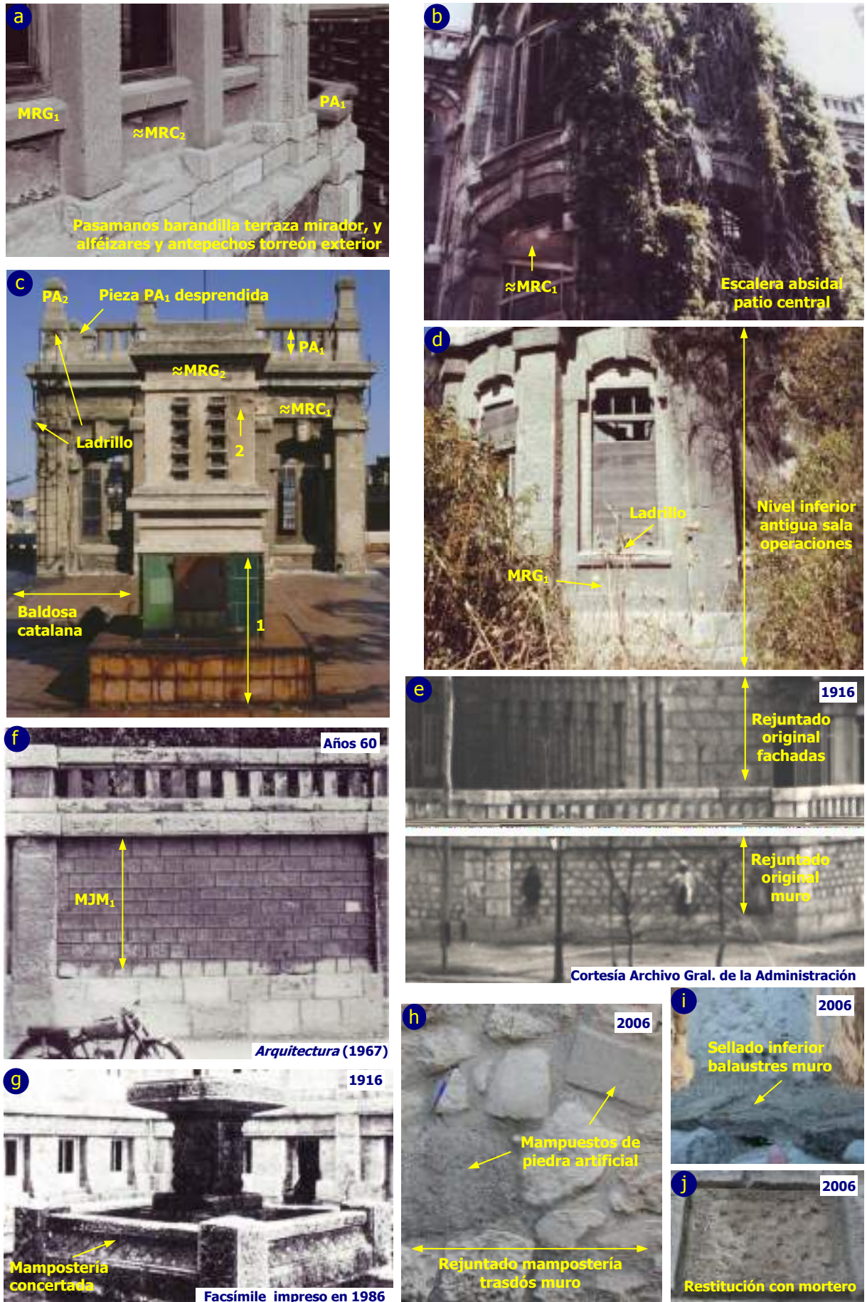
Fig.6.9. Piedra artificial, morteros de revestimiento y morteros de junta antes de la rehabilitación integral del Antiguo Hospital acometida entre 1984-1986 y/o en el año 2006. Fotografías a, b, c y d cedidas por Fernando de Castro López-Villarino, realizadas hacia 1983.
