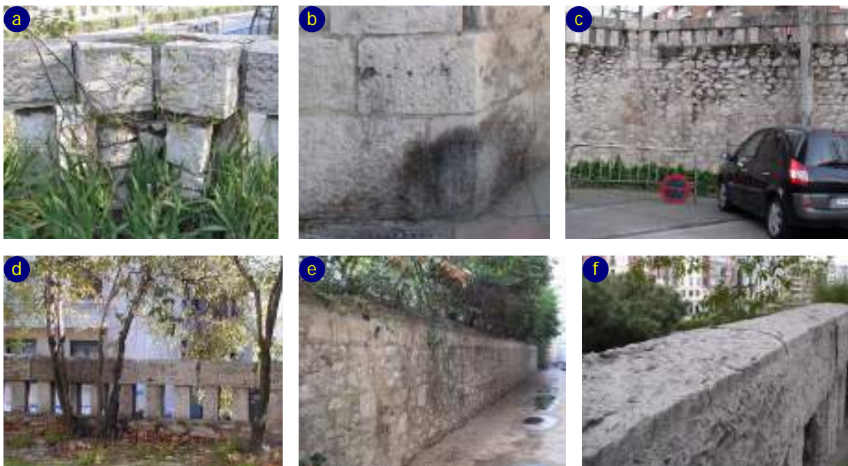
Fig.3.10. Lectura de paramentos en el muro perimetral del Antiguo Hospital.
