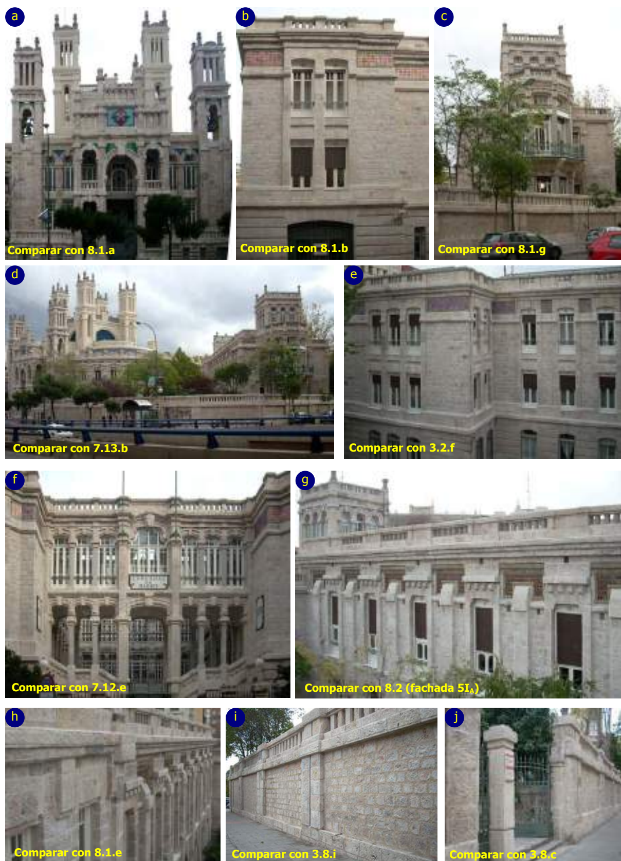
Fig.12.4. Aspecto de los paramentos del Antiguo Hospital tras su limpieza (año 2008).
