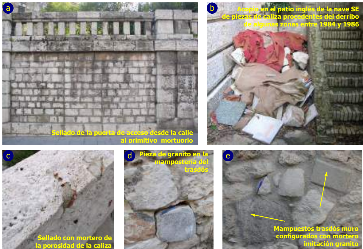
Fig.4.6. Aspectos relacionados con intervenciones efectuadas en la piedra caliza de los paramentos del inmueble observados en el año 2006.
