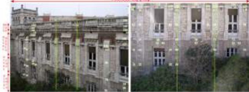
Fachada 5I A (NE)
