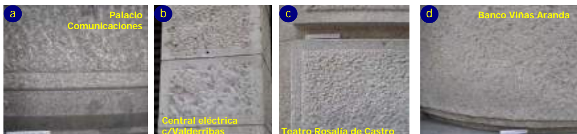
Fig.3.12. Acabado rústico y almohadillado de piezas pétreas en obras de Palacios.
