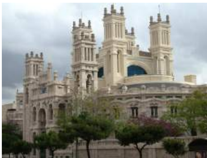
Aspecto que mostraban diversas fachadas del cuerpo de la iglesia y algunos paños del muro perimetral tras su limpieza (año 2008).
