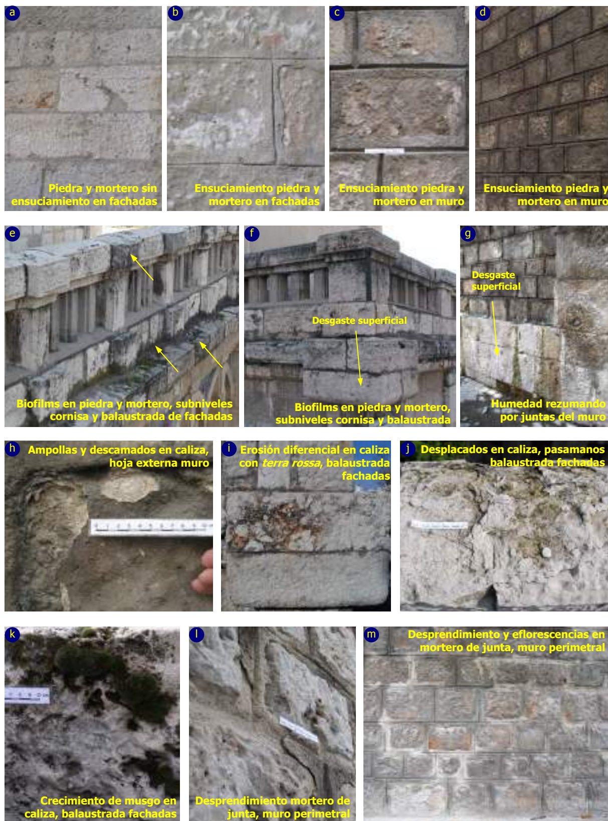
Fig.9.1. Principales formas de deterioro observadas en la caliza y morteros de fábrica en los paramentos del Antiguo Hospital (año 2006).
