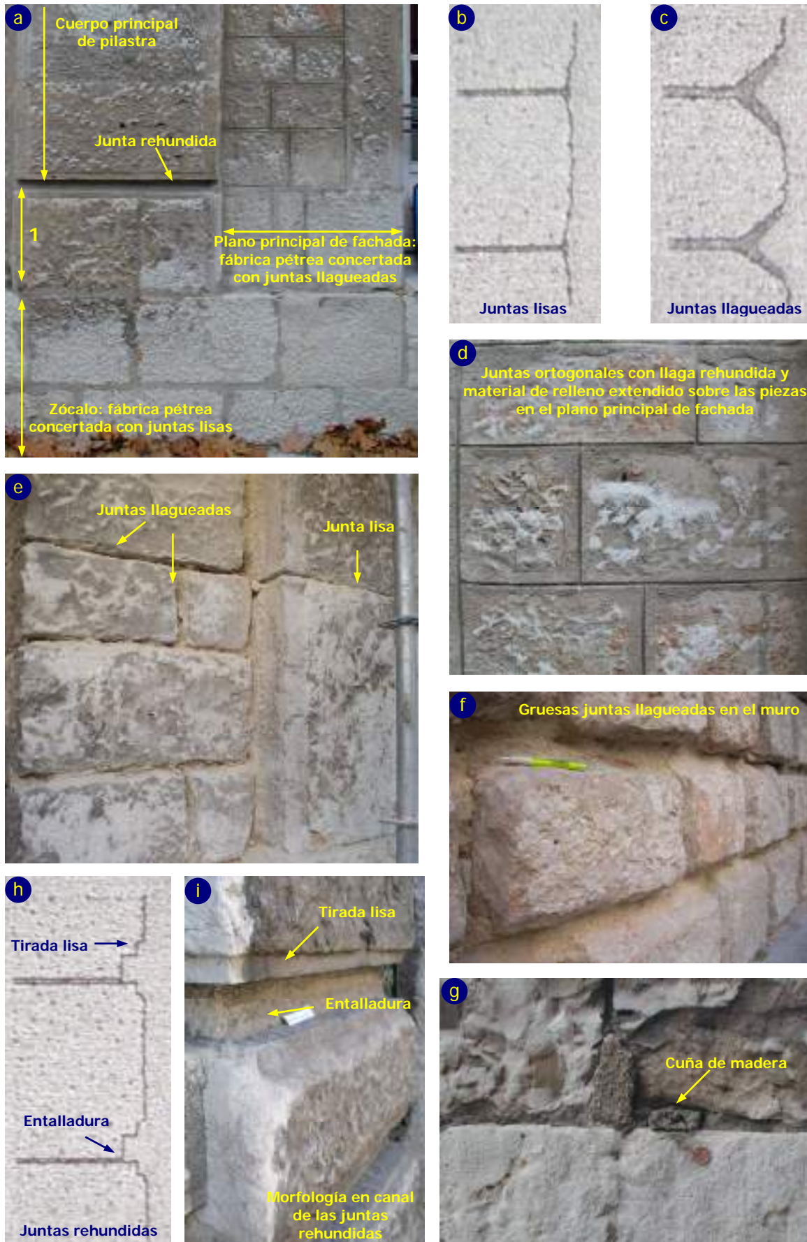
Fig.3.16. Diversos aspectos relativos a las juntas de cantería en los paramentos del Antiguo Hospital. Dibujos tomados de Cabrera (2004).
