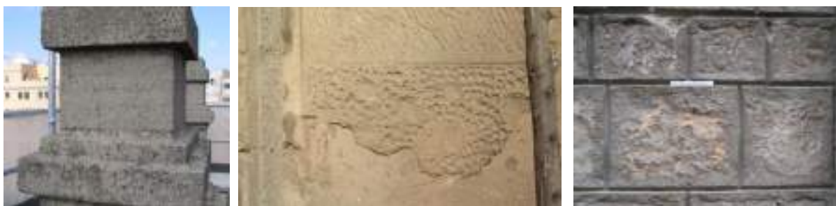
Aspecto de la piedra artificial (izda.), mortero de revestimiento (centro) y mortero de junta (dcha.) en los paramentos del Antiguo Hospital en el año 2006 y durante la intervención acometida entre 2006-2008.
