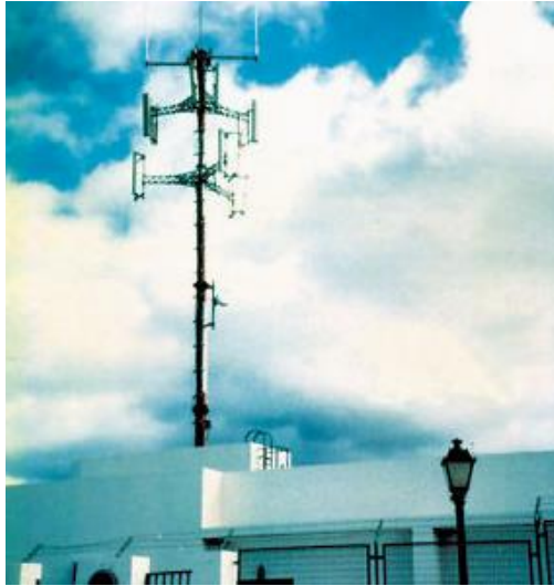
Figura 1. Antena sobre un edificio
