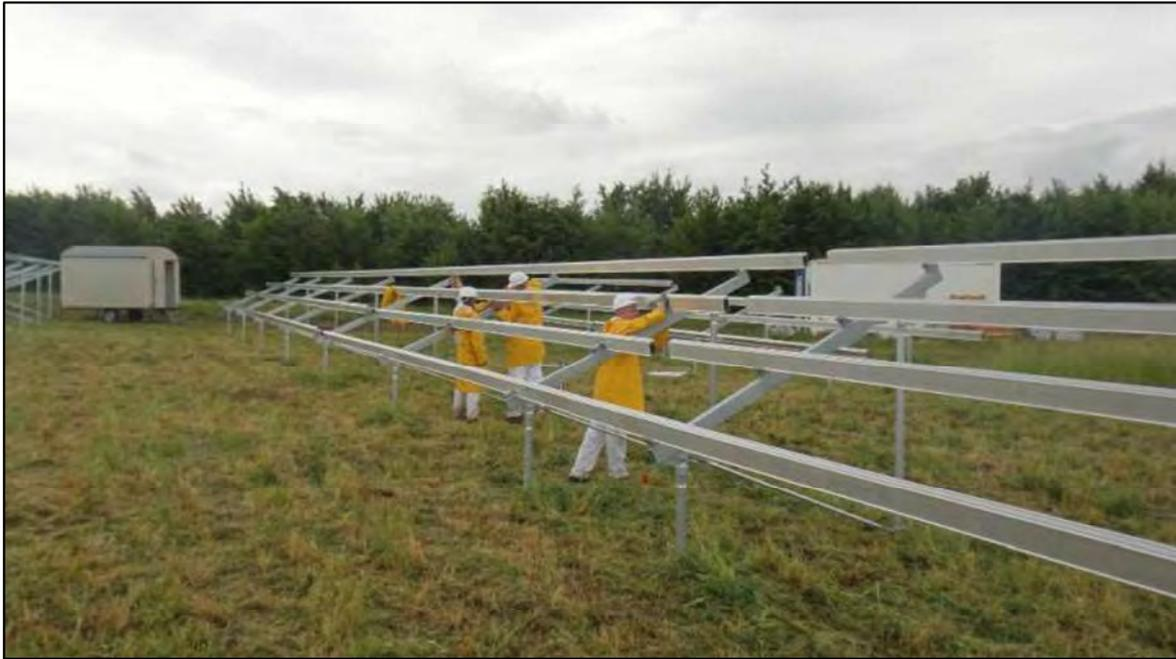
Ilustración 30. Montaje de estructura fija con perfiles hincados directamente en el terreno.
