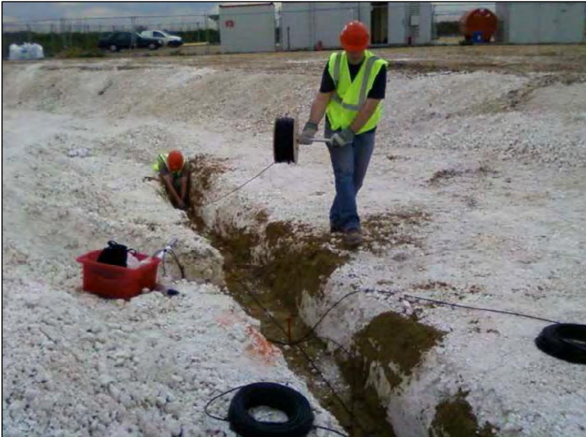
Ilustración 31. Tendido de cable en zanja.
