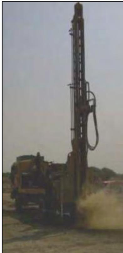
Ilustración 29. Detalle de hincado de perfiles con maquinaria especializada
