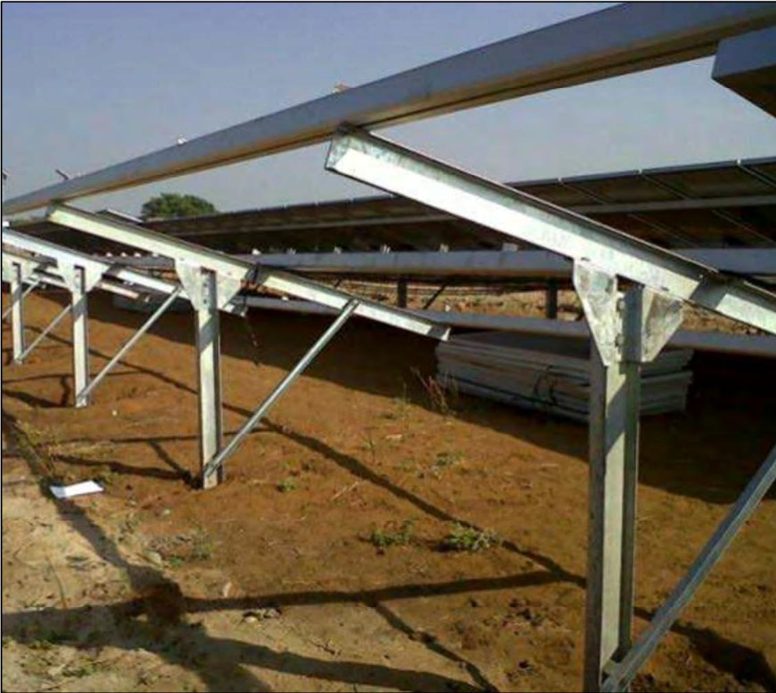
**Ilustración 27. Perfiles hincados directamente al terreno**
