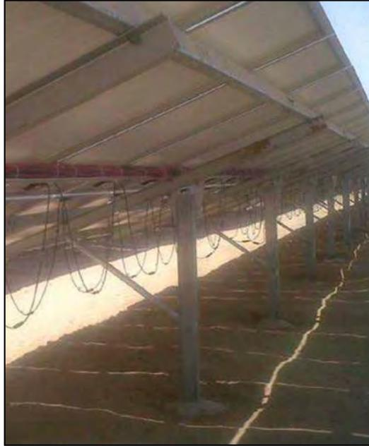
Ilustración 28. Cimentación con micro pilote. Detalle de cimentación y acabado.
