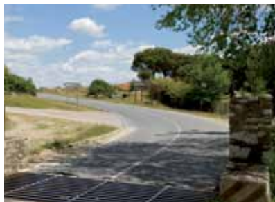
Inicio Tramo C
