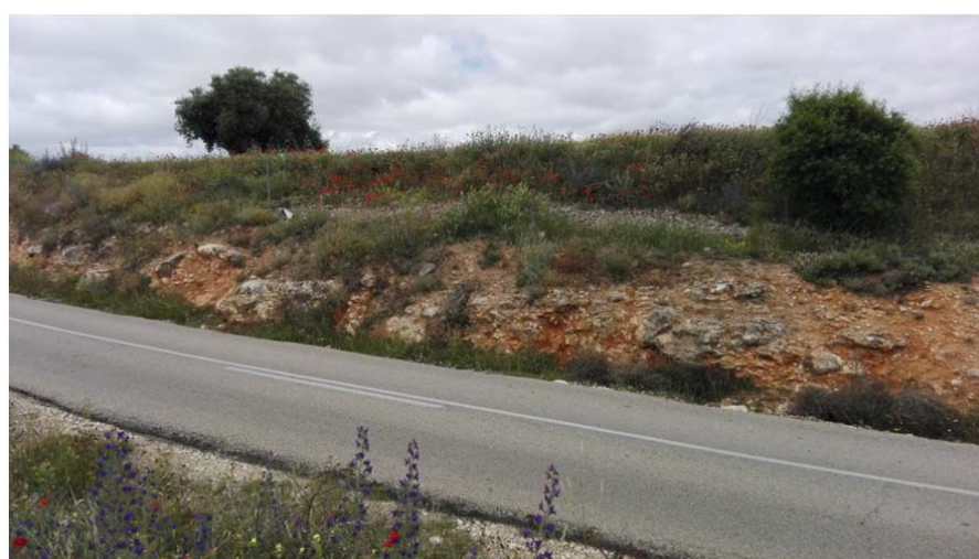
Talud de 1.5 m en calizas del páramo, actual M-316, PK 3+200
