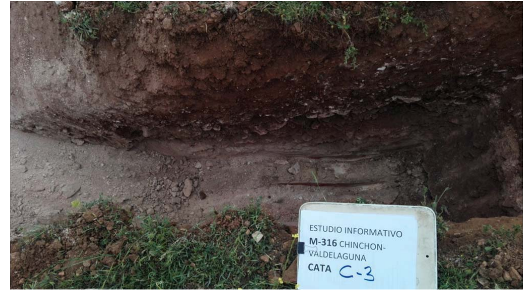
Cata C3: excavación
