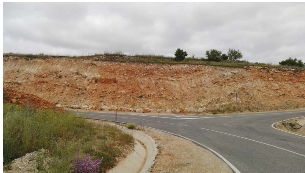
Talud en cruce de M-317 con M-316 (PK 4+040). Base de las calizas del Páramo
