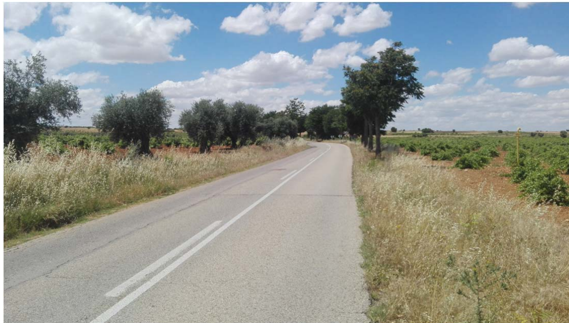
Actual M-316. Carretera sin arcenes, árboles en las lindes, sin terraplén. Viñedos en las lindes. PK 1+200
