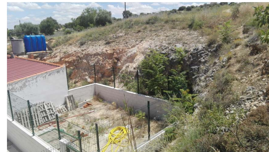
Talud de unos 4 m en calizas del páramo, próximo a la actual M-316, PK 3+900
