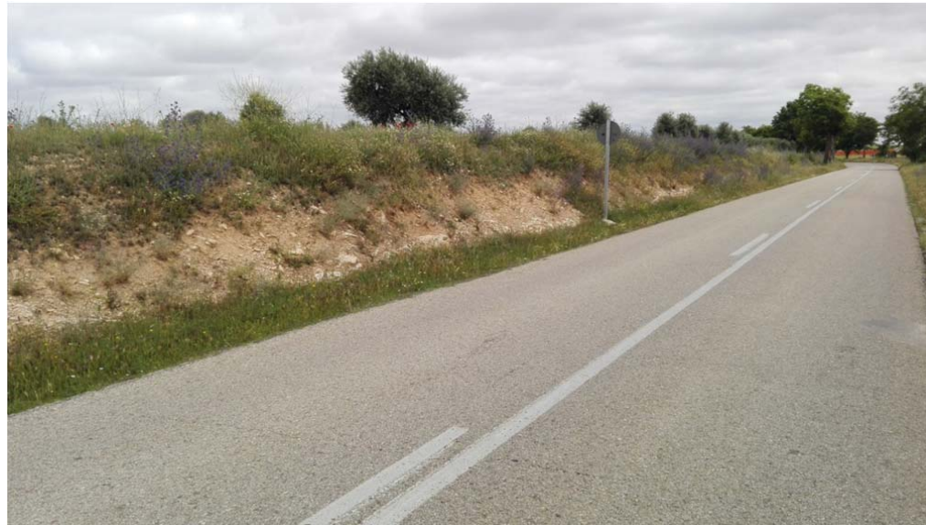
Calizas del páramo y caliches zona Valdelaguna, altura de talud: 2-2.5 m. Actual M-316
