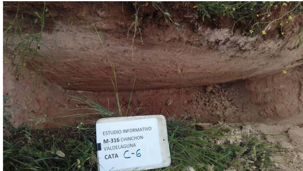
Cata C6: excavación
