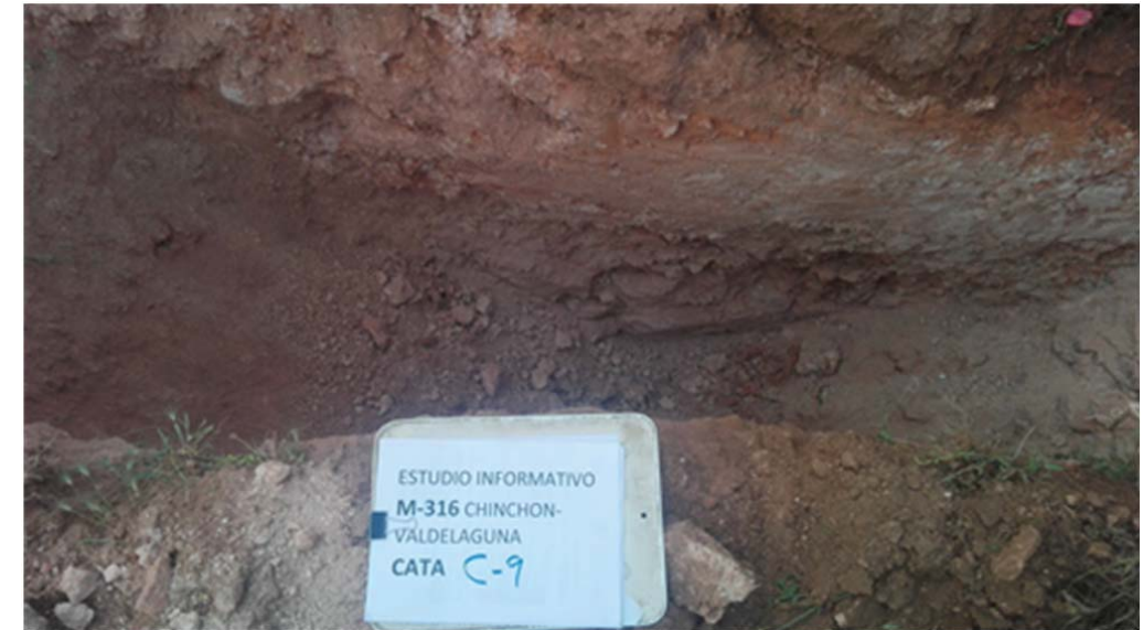
Cata C9: excavación
