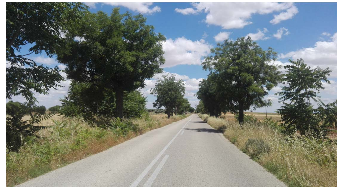
Actual M-316. Carretera sin arcenes, árboles en las lindes. Sin terraplén
