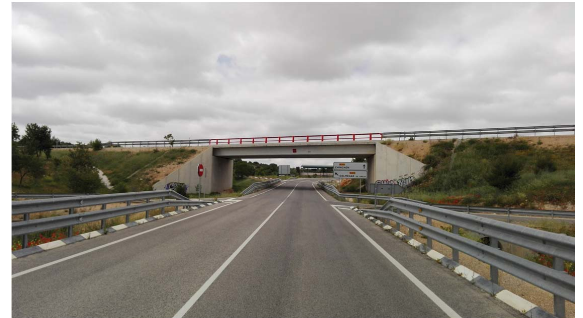
Actual M-316. Carretera con arcenes, Paso superior con la M-317. PK 4+040
