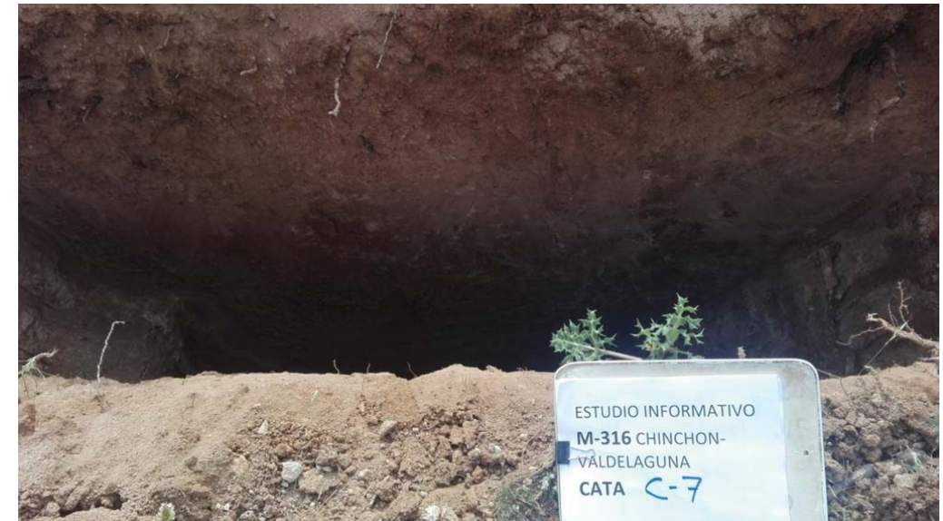
Cata C7: excavación
