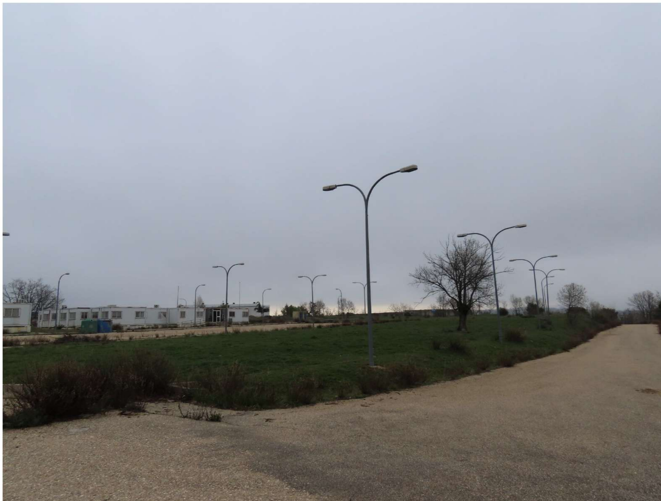
Imagen 3. Vista del área con casetas temporales a demoler
