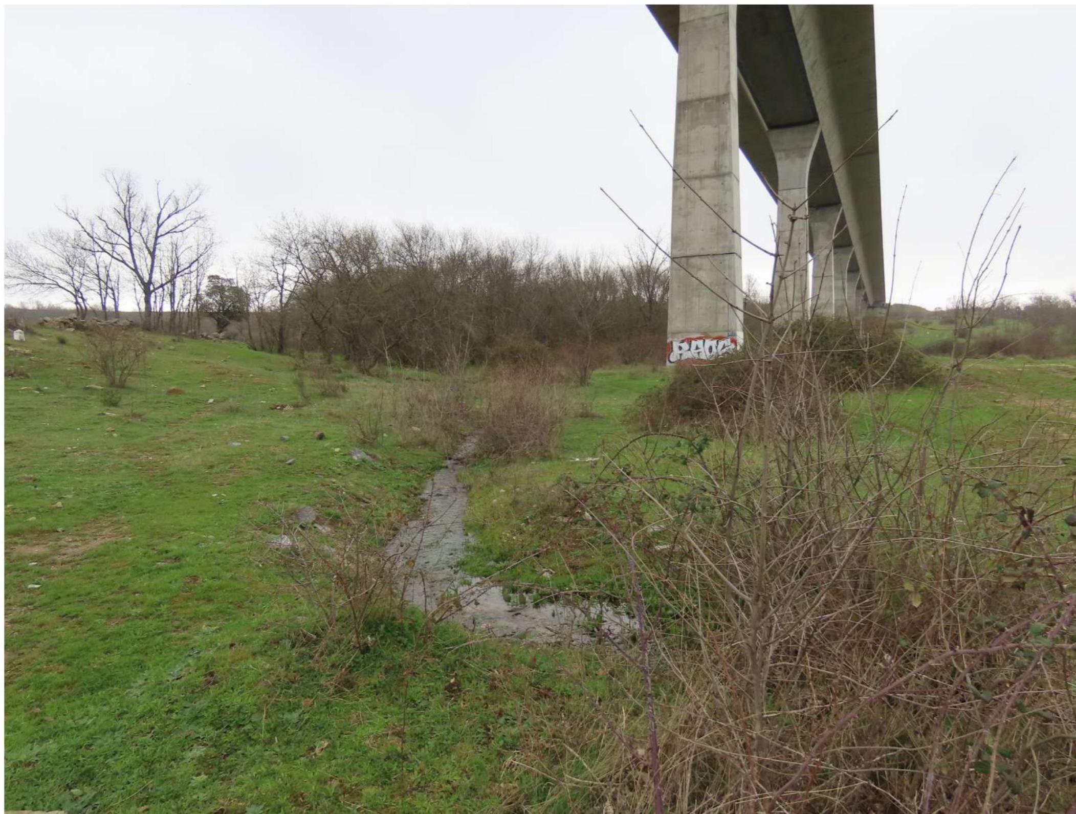
Imagen 13. Riachuelo Matarrubias en las proximidades del viaducto orientación este
