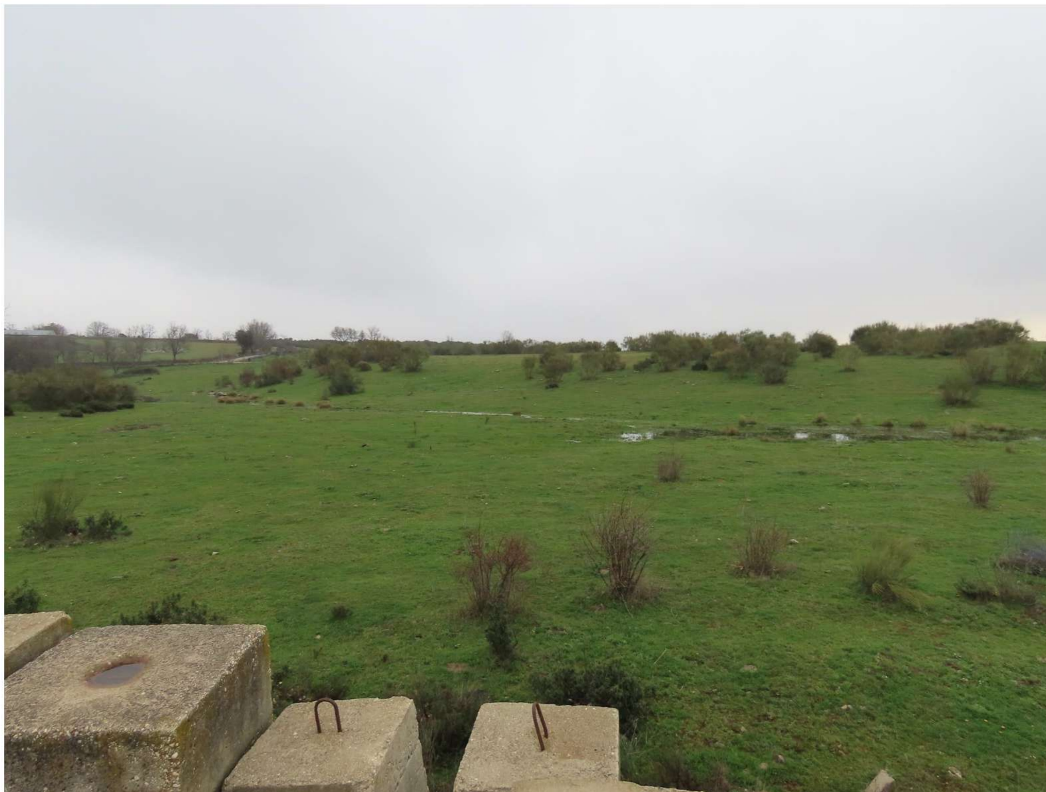
Imagen 5. Vista del área implantación de paneles fotovoltaicos zona D orientación este
