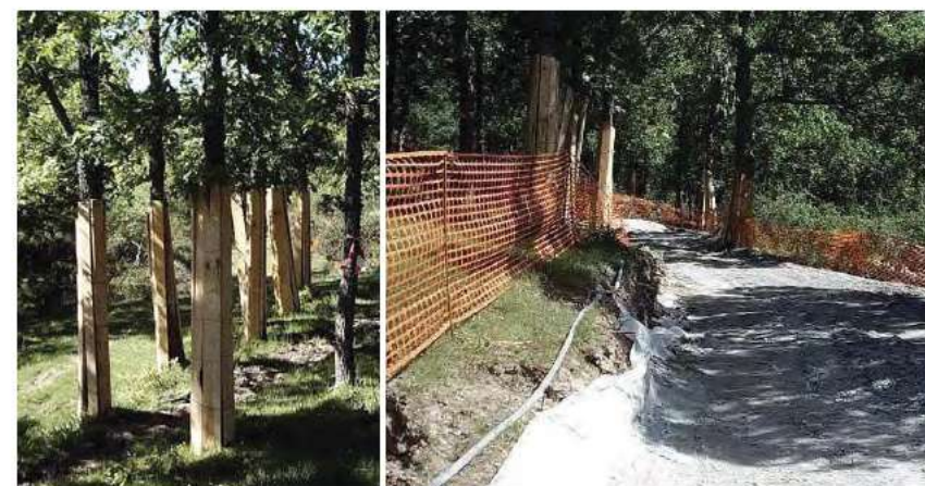
Figura 27. Protección de arbolado y jalonamiento de protección en obras del Túnel de Guadarrama en Segovia
