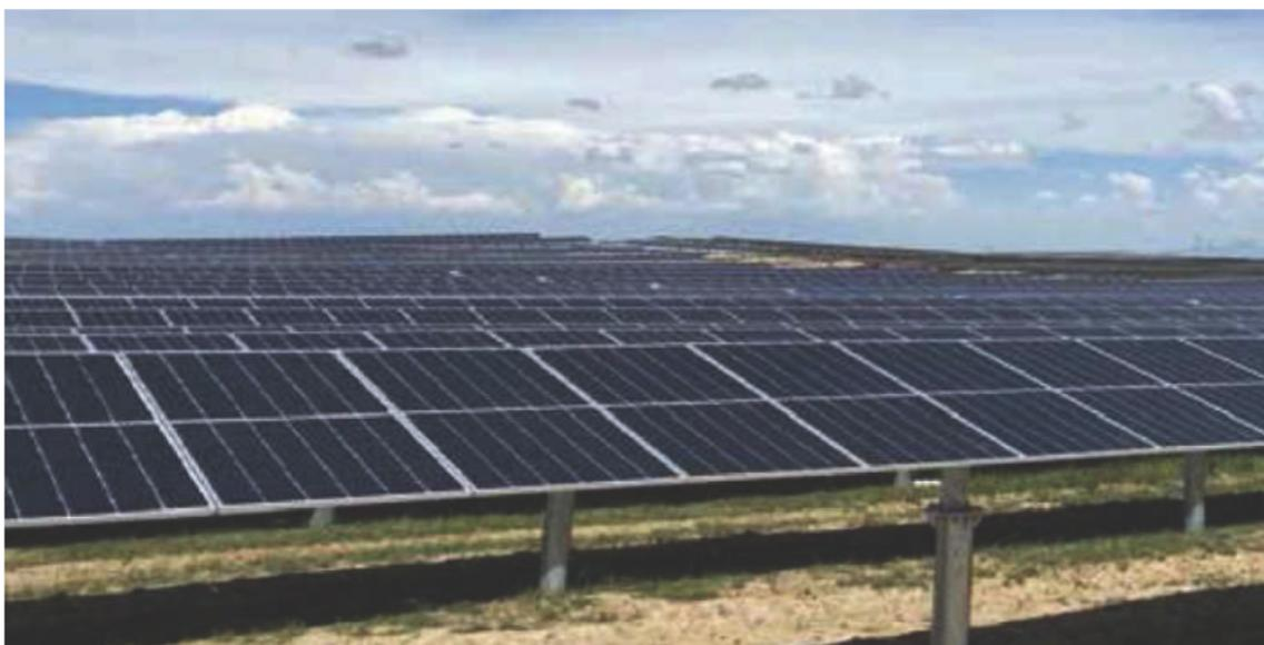
**Figura 13.** Seguidor solar. Fuente: Proyecto ejecución.
