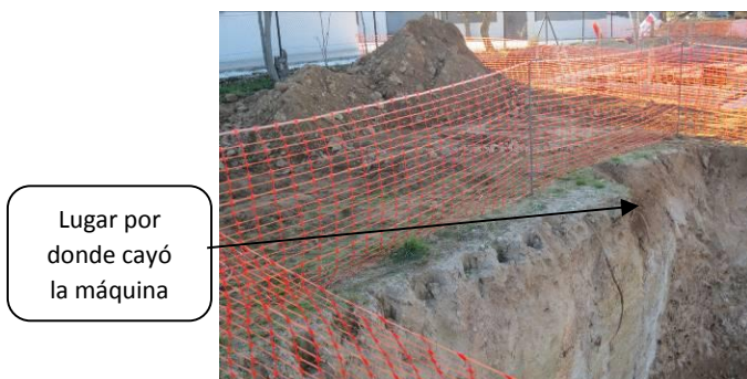
Figura 1: Hueco de la piscina y montón de tierra
