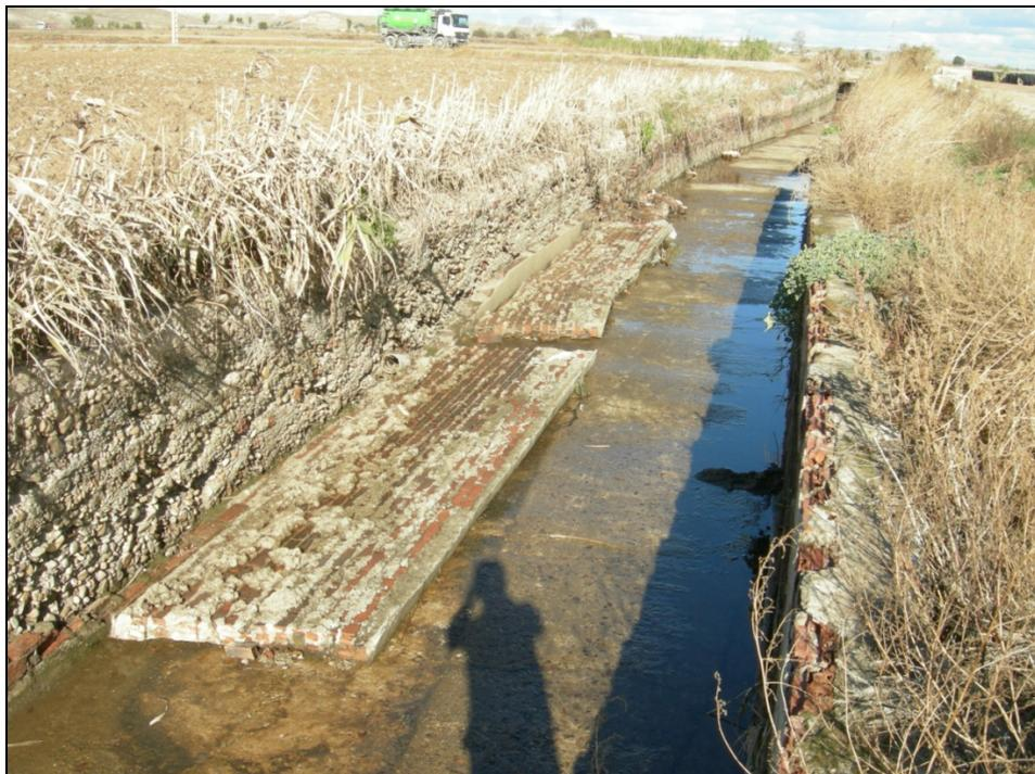
Foto 2.- Real Acequia del Jarama. Vuelco de muro de ladrillos y exposición del terreno natural (pk 14+500)
