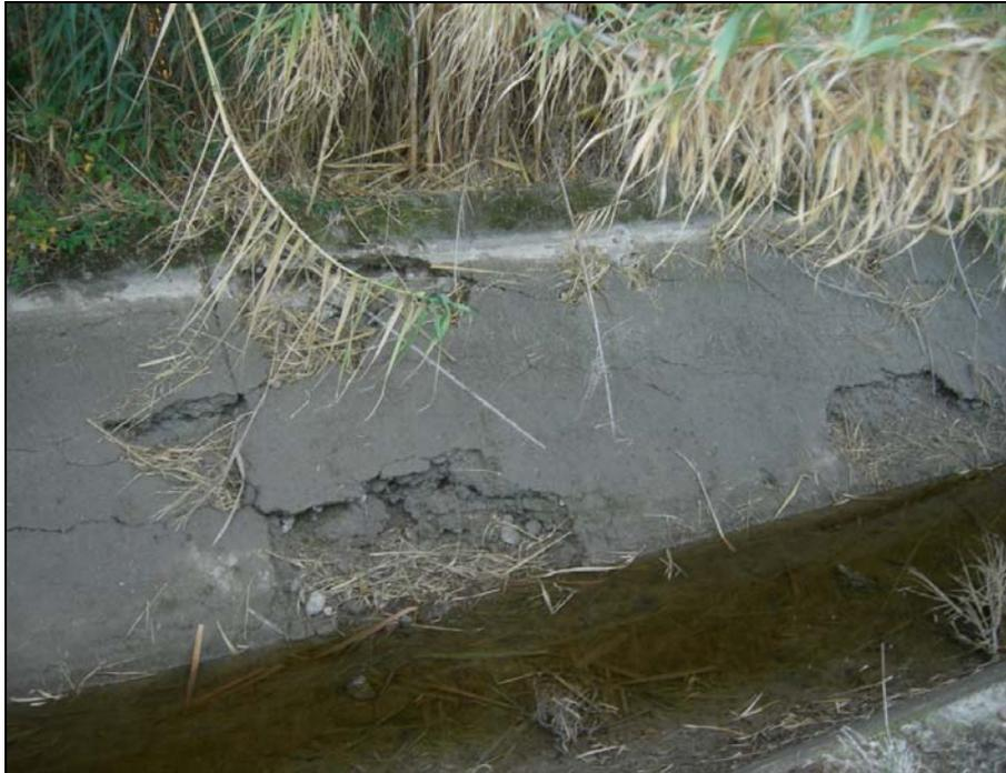
Foto 3. Caz Chico-Azuda. Deterioro del revestimiento del Canal
