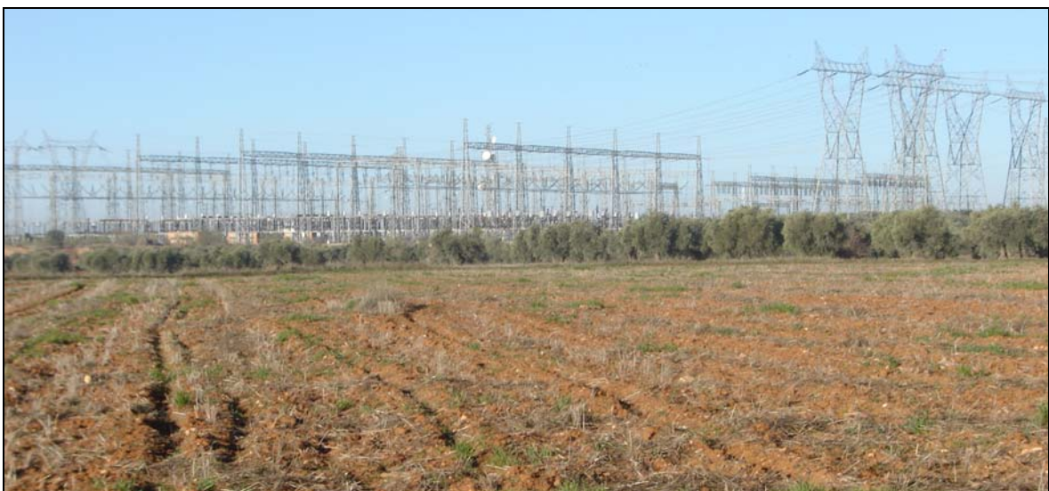
Subestación eléctrica situada al Norte de la localidad de Morata de Tajuña
