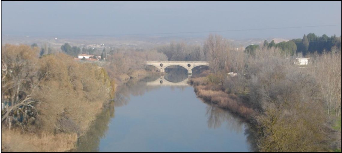
Ribera del Tajo en el puente de la Carretera M-241
