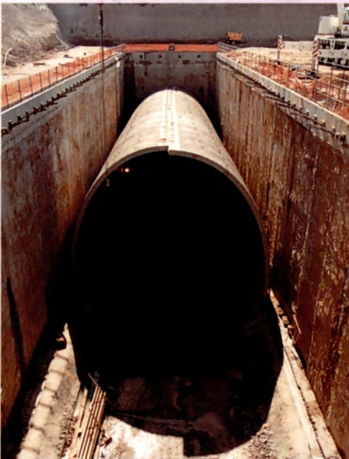
POZO DE SALIDA EPB
