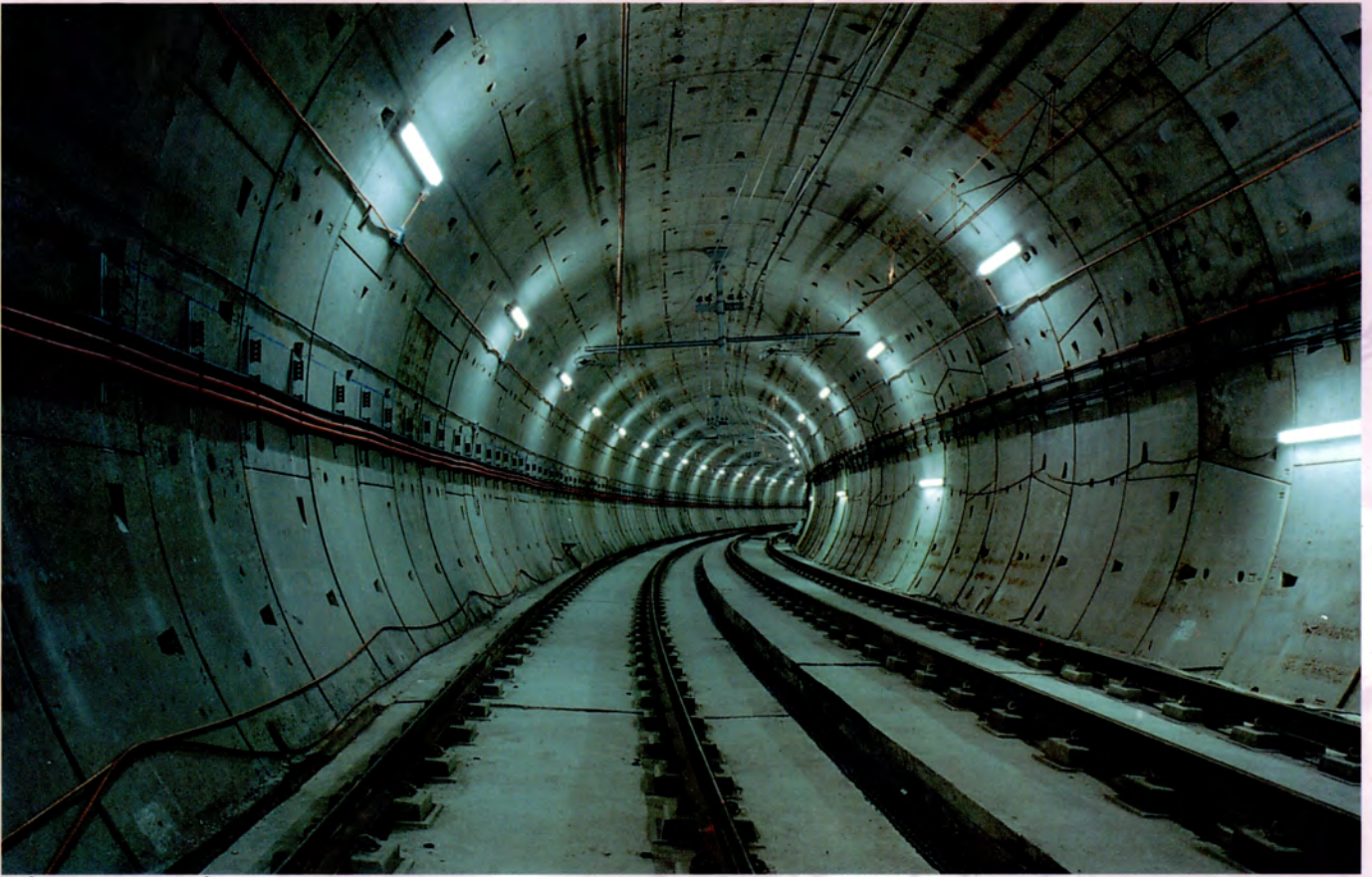
TÚNEL EPB Y VÍA HORMIGONADA
