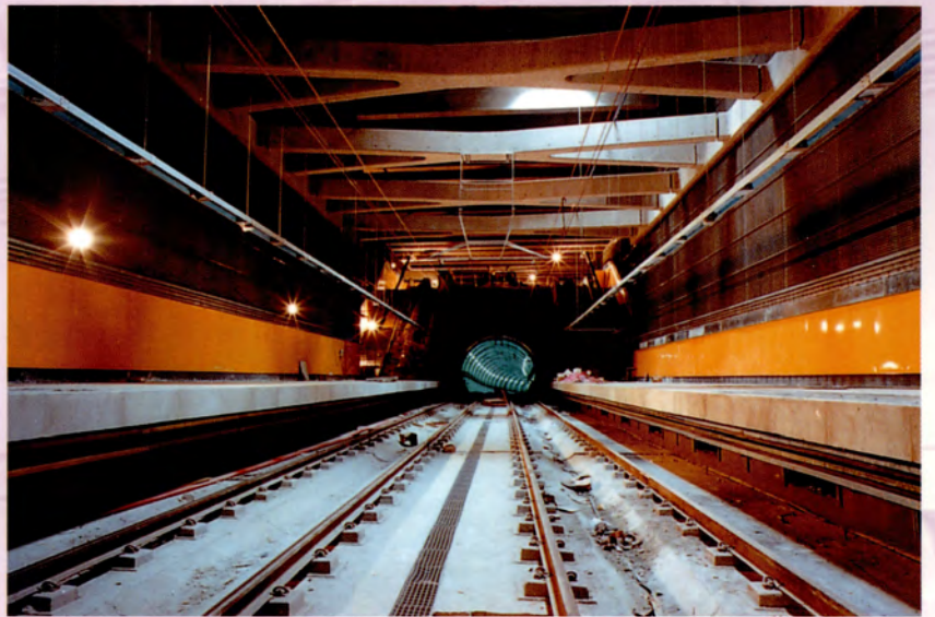
ESTACIÓN VALDEBERNARDO. ANDENES
