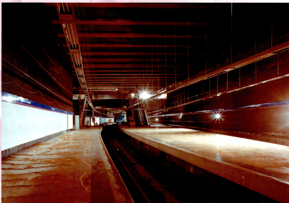
ESTACIÓN PUERTA DE ARGANDA. ANDENES
